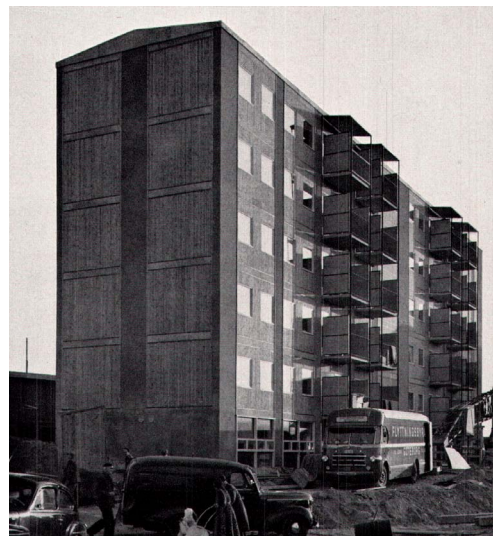
Abb. 44: Wohnhaus in Järnbrott (Göteborg), Schweden
