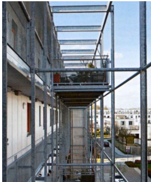
Abb. 17: Laubengang mit angehängter Konstruktion
