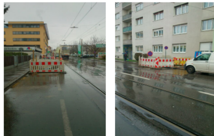
Abbildung 7.13.: Umwehrung gem. §8 BauV
