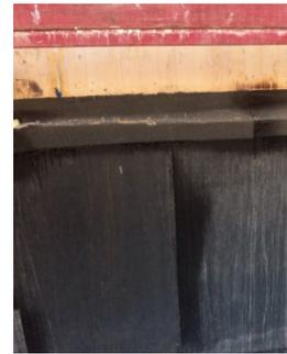
Abbildung 2.26 aufgeflämmte Bitumenbahn an einem Gebäude in Holz-Massivbauweise
