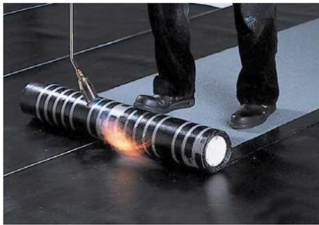
Abbildung 2.25 aufgeflämmte Bitumenbahn (16)
