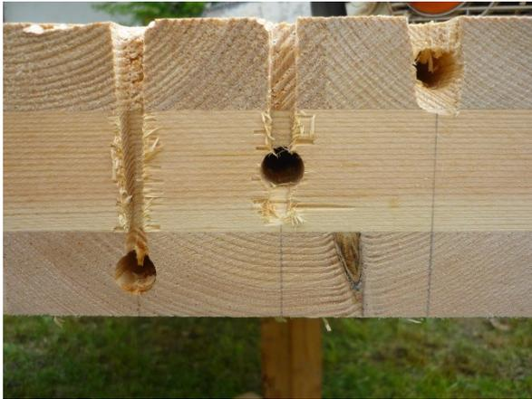
*Abb. 13: Schlitz für Kabelführung*
