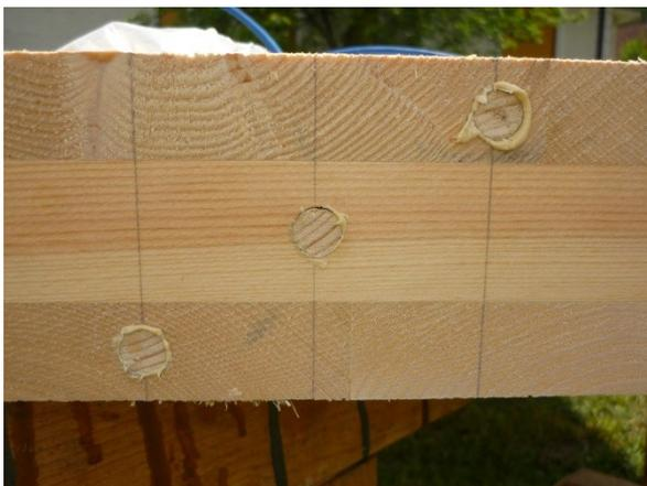
*Abb. 16: verschlossene Bohrlöcher*
