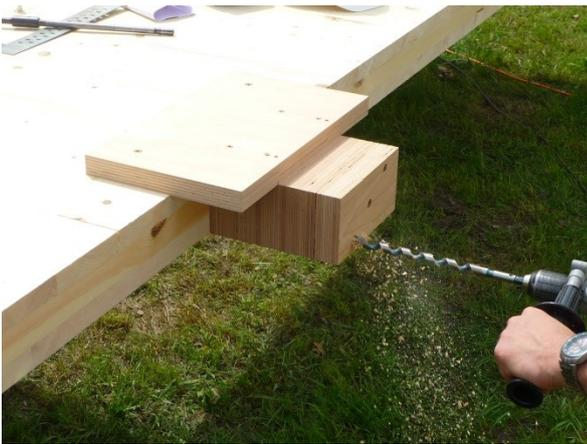
Abb. 11: Bohrung mittels Bohrschablone
