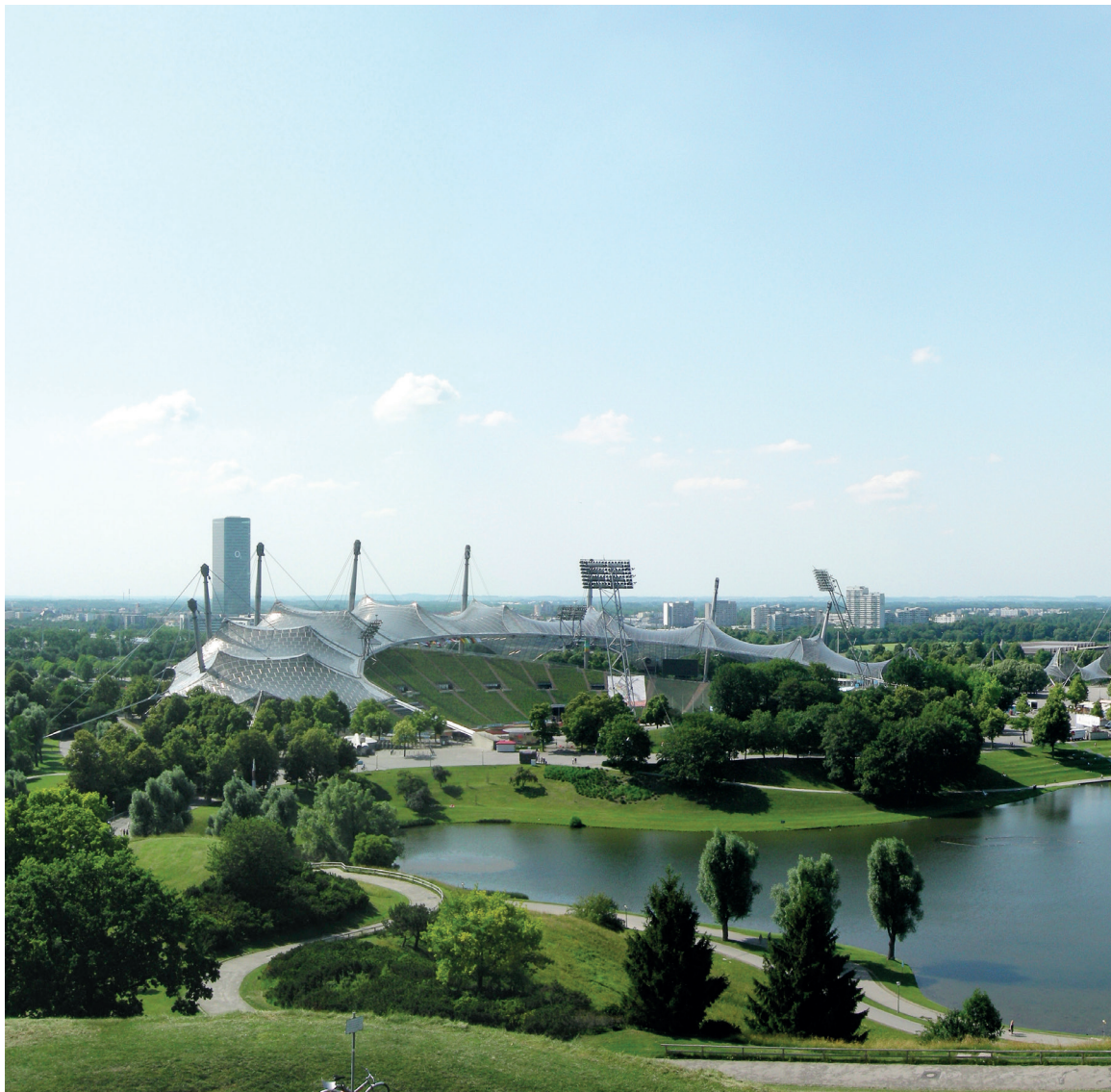
Abb.10: Blick vom Olympiabergr auf die Zelt dachkon- struktion
