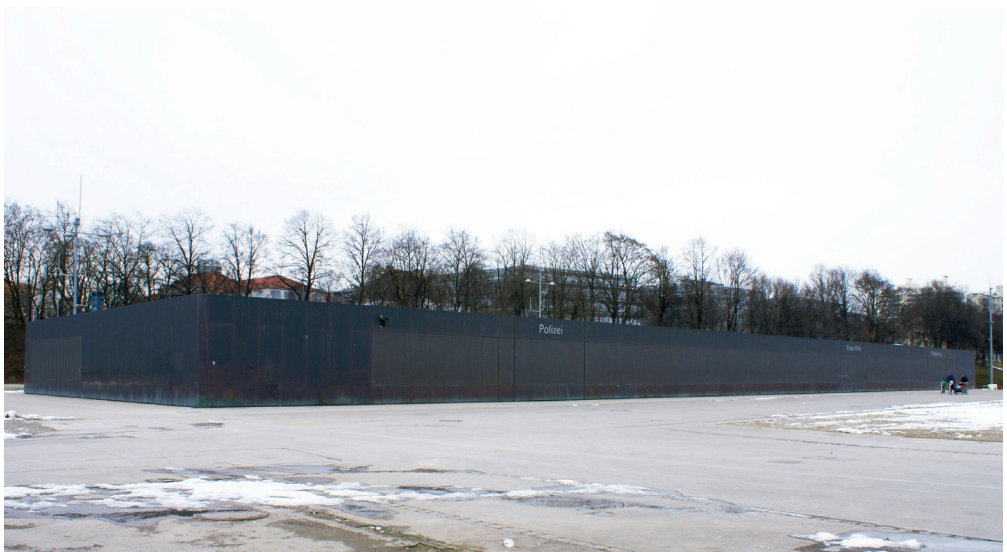
Abb.21: Das verschlossene Servicegebäude
