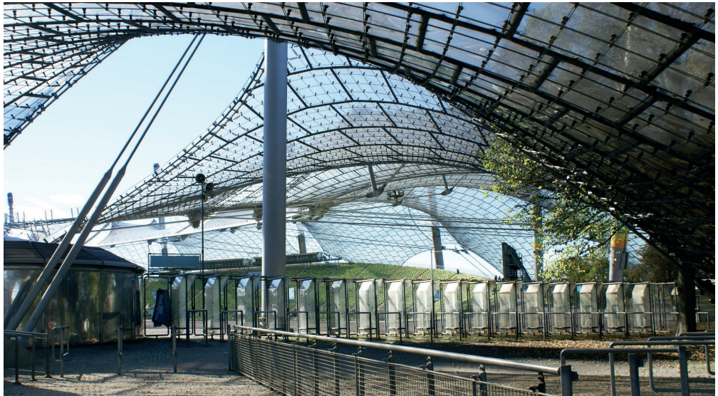
Abb.14, 15: Das Stadion mit der Zeltdach- konstruktion
