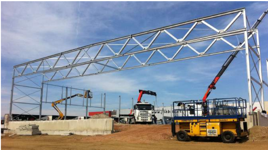
Abbildung 4-34: Montagearbeiten bei der Errichtung einer Stahlhalle
