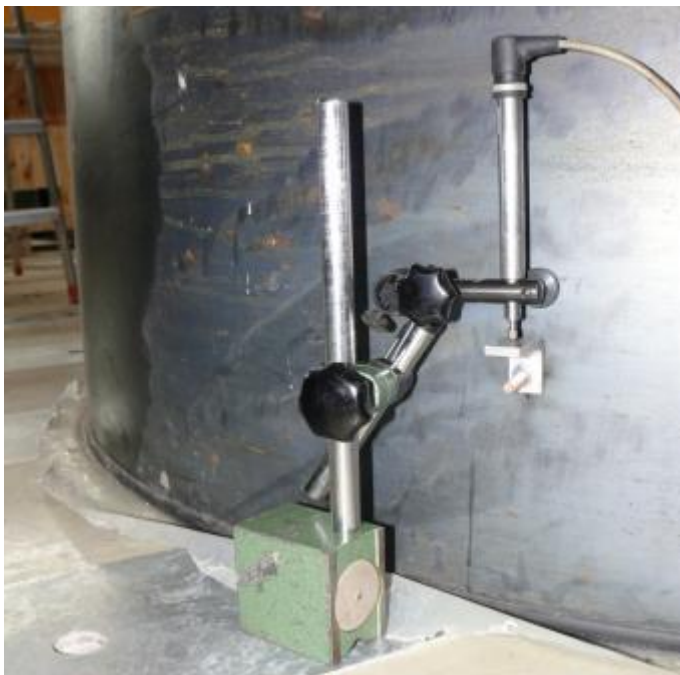
Abb. 265 Messung der vertikalen Verschiebung an der Außenschalung (Kanal 4,12,20)
