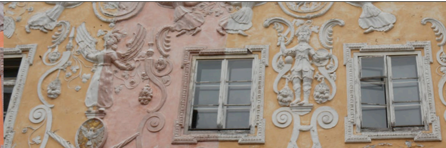
Abb 175. Fassade „Heilig Geist Haus“ vor der Renovierung 2015
