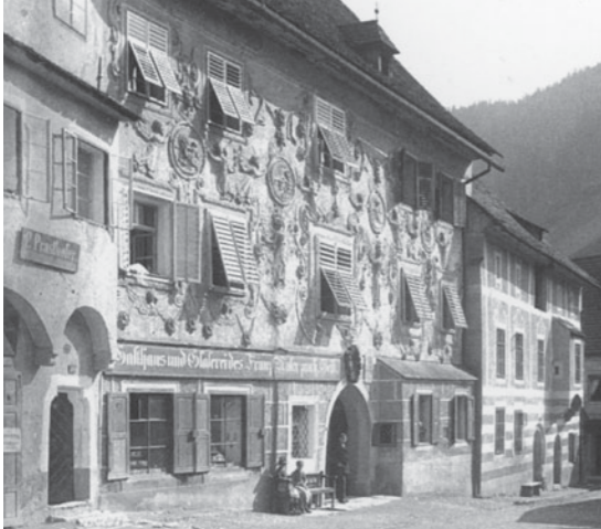
Abb 191. „Heilig Geist Haus“ Fassade und Vorbau
