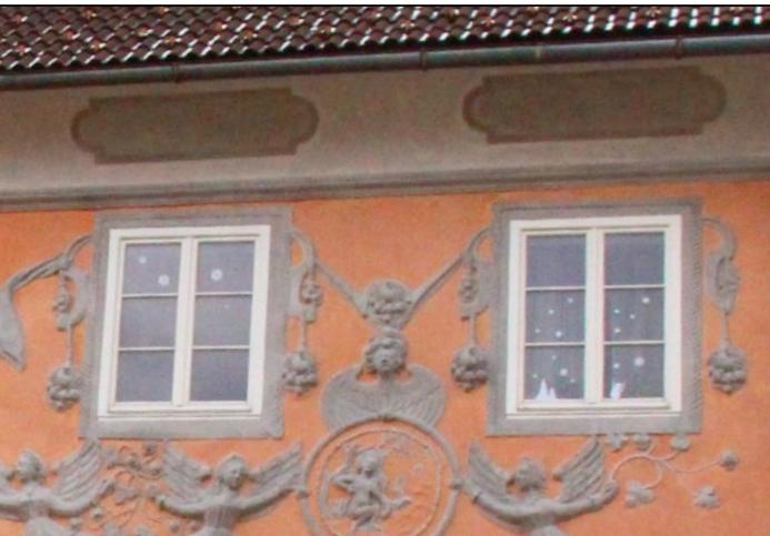
Abb 31. Fenster Schauffassade Dachgeschoß
