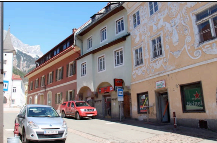
Abb 86. Blick auf die Dr.-Karl-Renner-Straße
