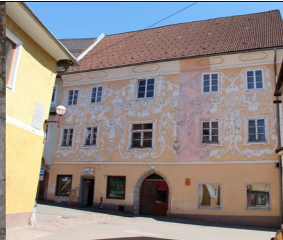
Abb 134. Fassade „Heilig Geist Haus“ vor der Renovierung 2015
