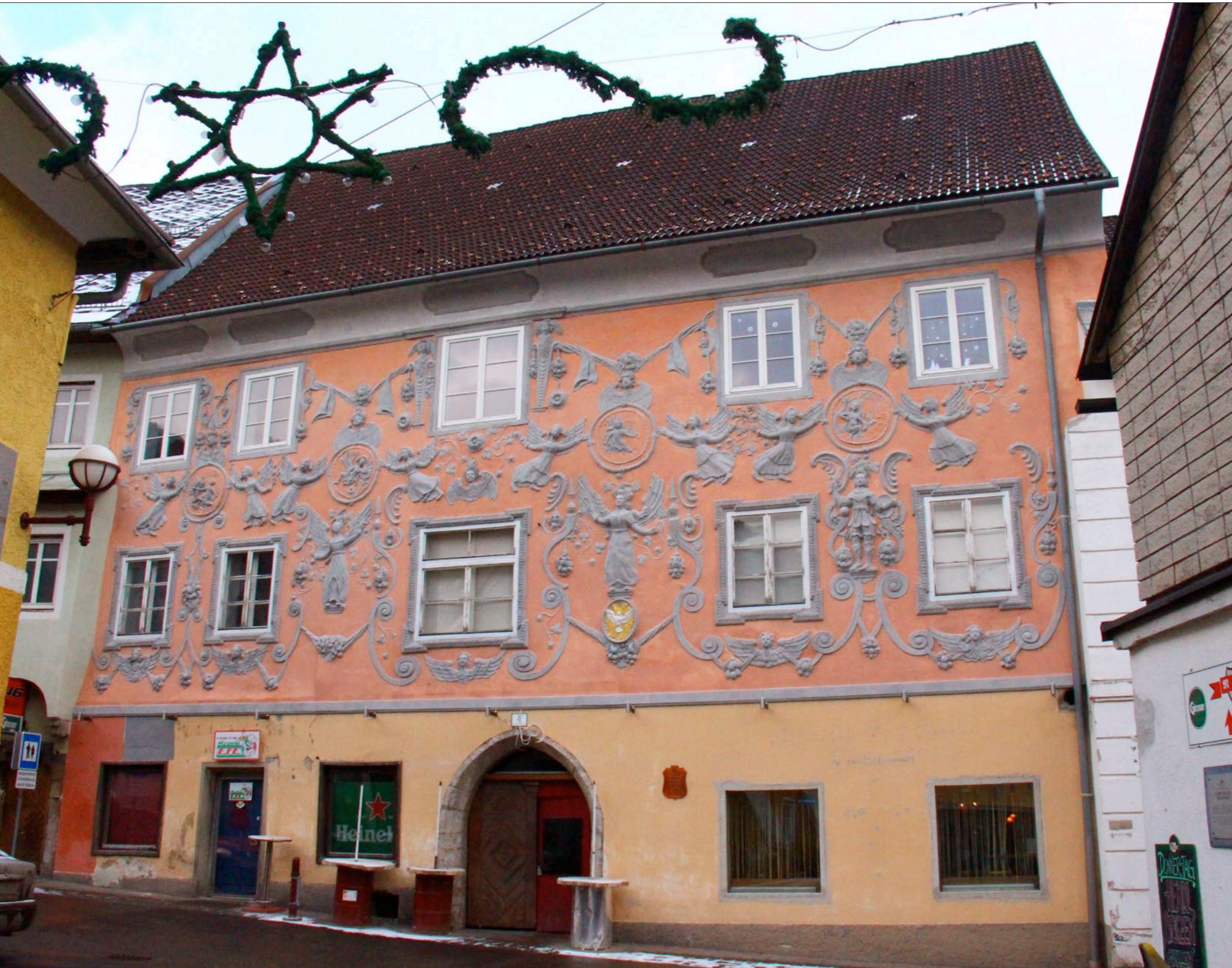
Abb 5. Fassade „Heilig Geist Haus“
