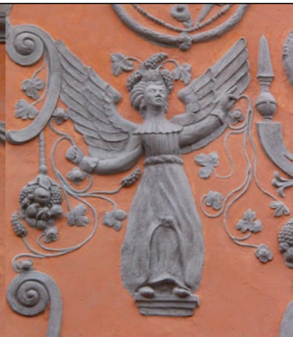
Abb 183. Fassade „Heilig Geist Haus“
