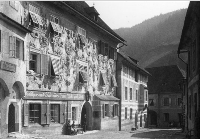
Abb 199. Fassade „Heilig Geist Haus“
