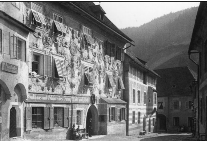
Abb 213. Fassade „Heilig Geist Haus“
