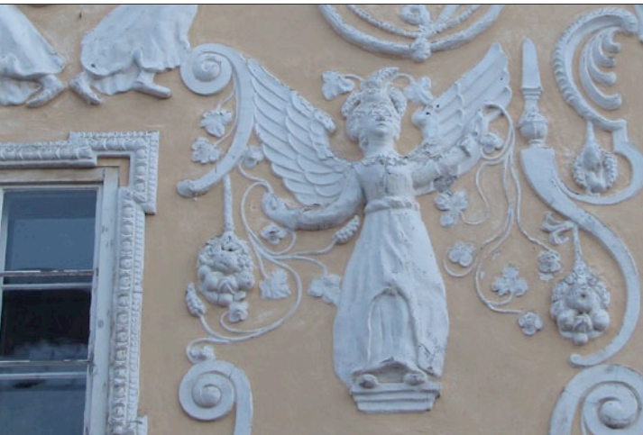
Abb 173. Fassade „Heilig Geist Haus“, vor der Renovierung 2015
