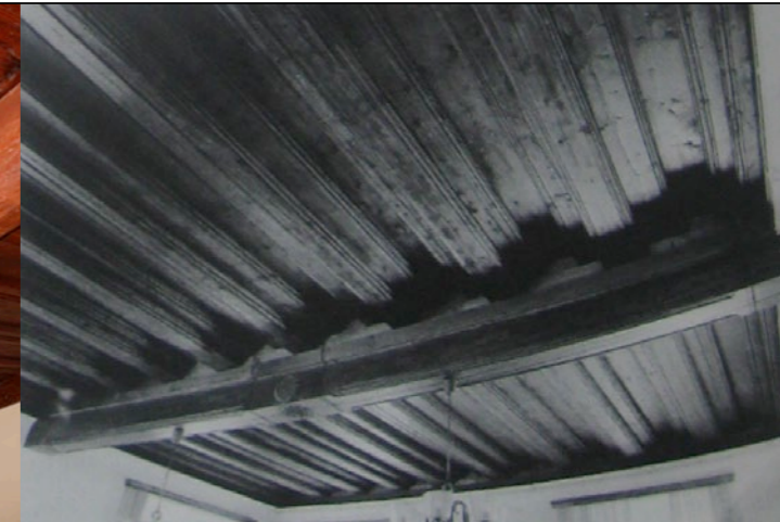
Abb 124. Vergleichsbeispiel Holzbalkendecke Graz, Sackstraße 20
