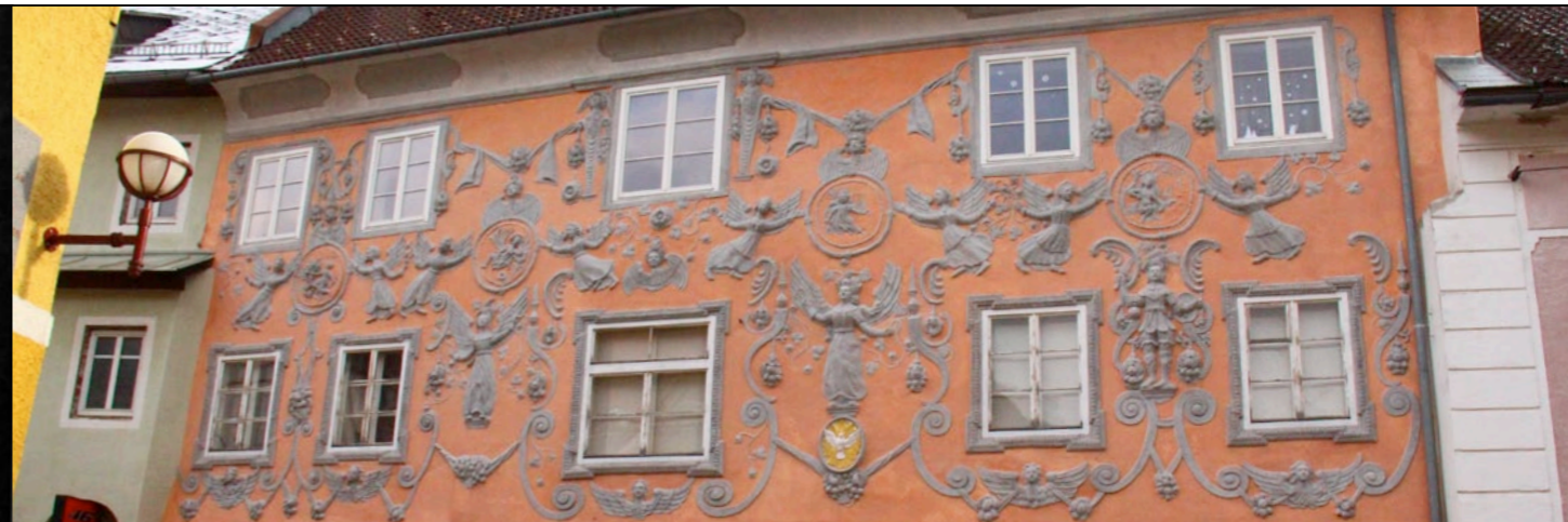
Abb 172. Fassade „Heilig Geist Haus“
