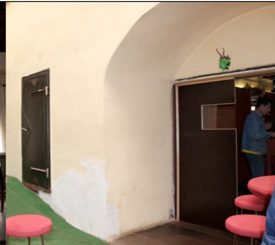
Abb 59. Innenhof tür in Richtung EGIX
