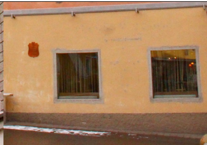
Abb 33. Fenster Schauffassade Erdgeschoß
