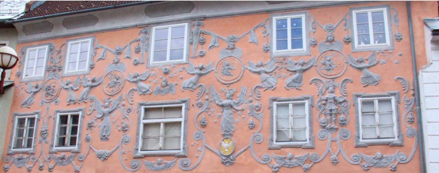
Abb 188. Fassade „Heilig Geist Haus“
