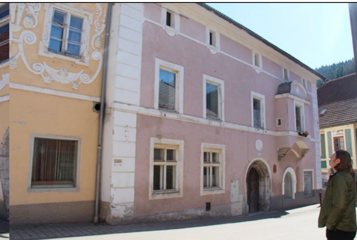
Abb 87. Blick auf die Dr.-Karl-Renner-Straße
