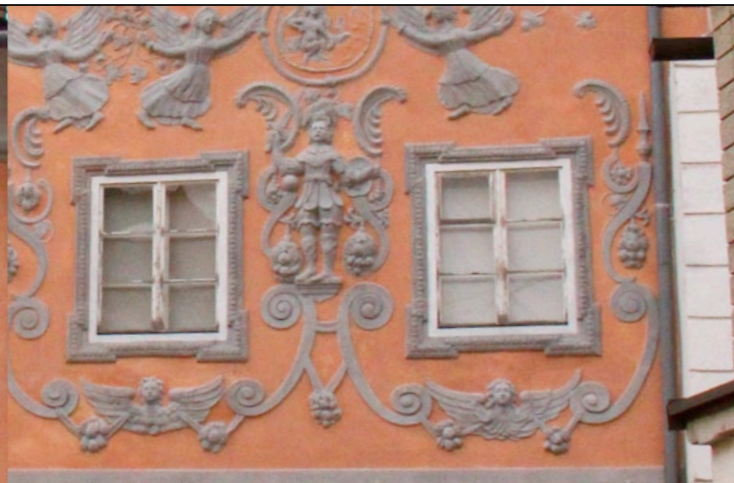
Abb 32. Fenster Schauffassade Obergeschoß
