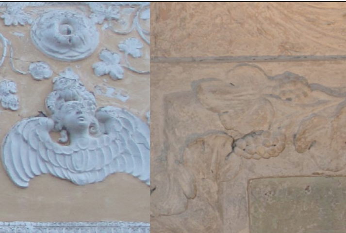
Abb 136. Fassade „Heilig Geist Haus“
