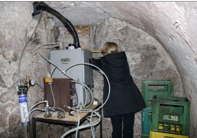
Abb 6. Aufmaßarbeiten im Keller
