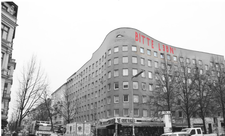
25 Wohnhaus geplant von Alvaro Siza
