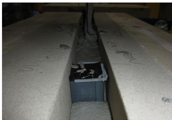
Abbildung F.8 Betonage eines Elements. Einfüllseite mit Aussparungskörper
