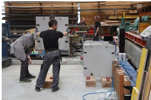
Abbildung F.16 Einheben des zweiten Elements mittels Kran
