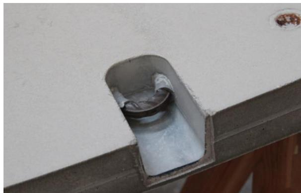
Abbildung F.14 Aussparung im UHPC-Schalenelement mit noch ungeschliffener Fuge
