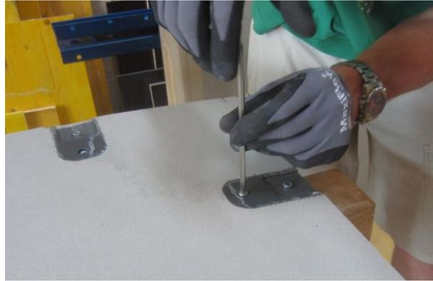
Abbildung F.12 Lösen der Verbindungsschrauben Aussparungskörper Unterteil – Ober- teil und entfernen des Unterteils.
