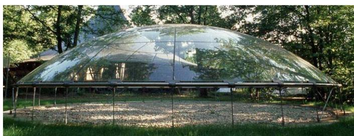
Abbildung 2.20 Prototyp einer Glasschale mit geklebten Fugen an der Universität Stuttgart [Blandini 2008]
