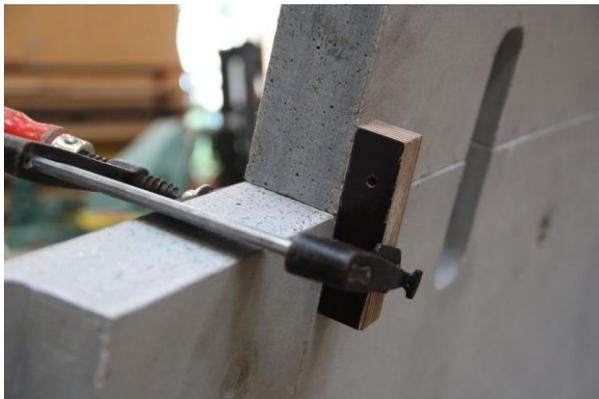
Abbildung F.21 Einrichten in Dickenrichtung mit Schraubzwinde und Holzbeilage
