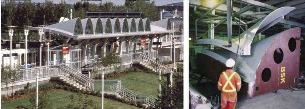
Abbildung 2.22 LRT Station Shawnessy in Calgary: Übersicht der Überdachung und Fertigteil nach dem Ausschalen; [Vicenzino et al. 2005]
