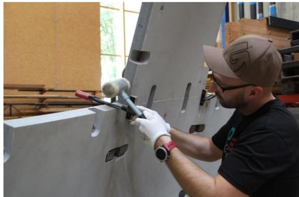
Abbildung F.22 Einrichten der Position in Fugenlängsrichtung
