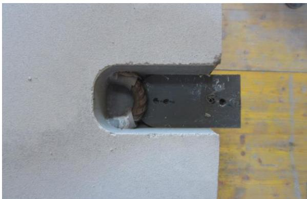
Abbildung F.13 Entfernung des Aussparungskörper- Oberteils in Richtung der Fuge
