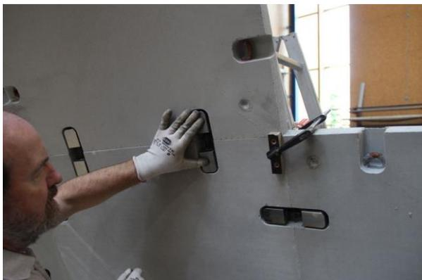
Abbildung F.23 Einlegen des Spannschlusses
