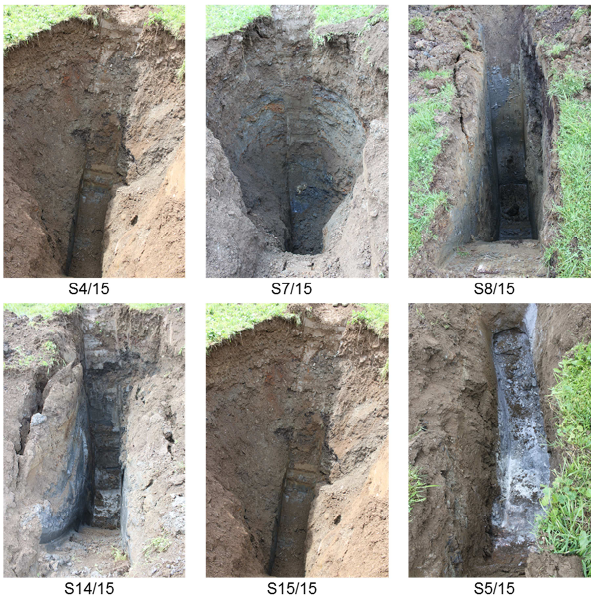
Abbildung 2-12: Schürfgruben S4/15, S7/15, S8/15 sowie S14/15 und S15/15
