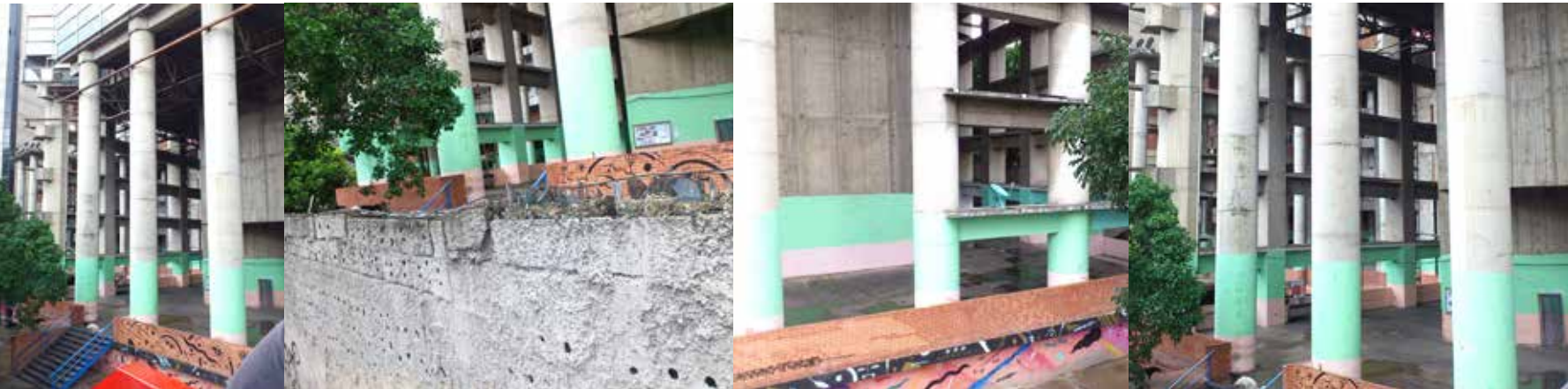
Abb. 132-134. Haupteingang im Süden
