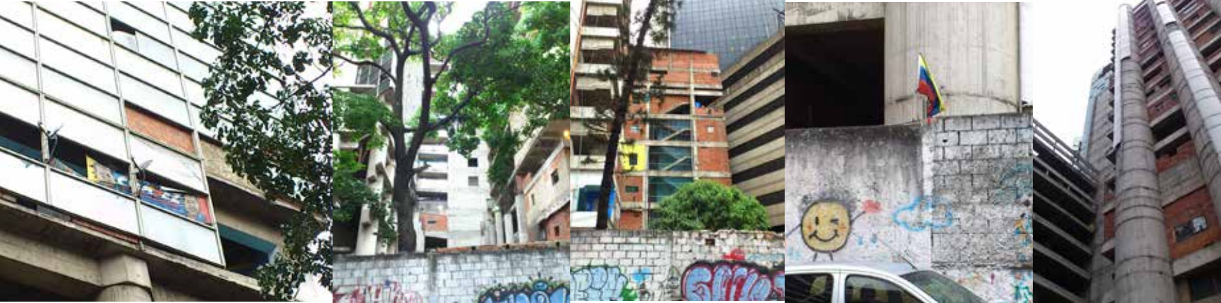
Abb. 135-139. Chávez-Plakat an ausgebauten Wohnungspartellen
