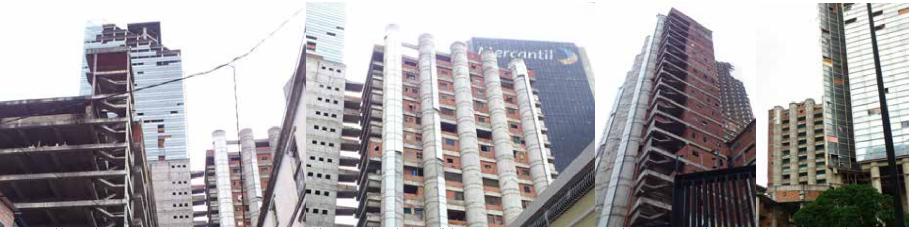
Abb. Detail 114. Nordansicht
