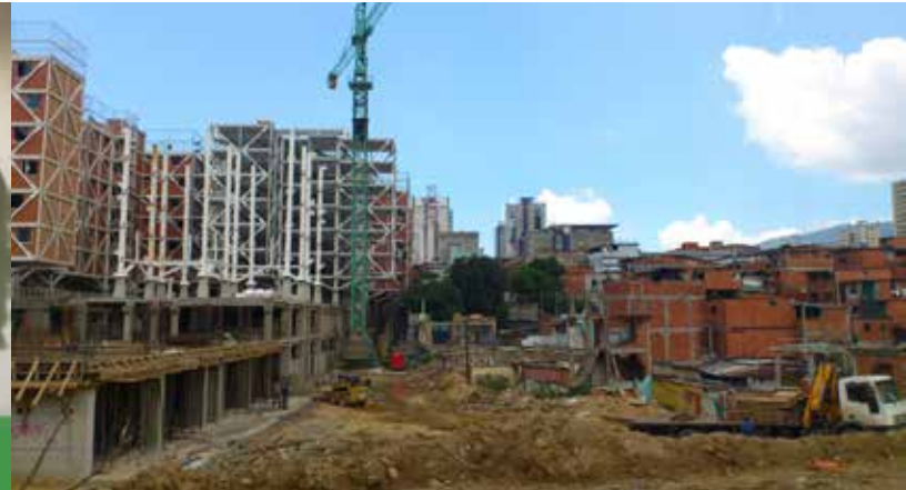
Abriss bestehender Barrios informales und Neubau der Misión Vivienda
