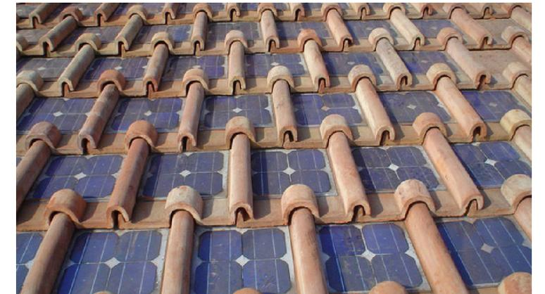
79 | Integration der PV-Module in Dachziegel
