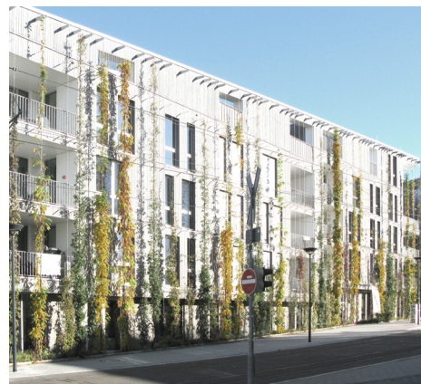
Abb. 73 Fassadenbegrünung am Paula-Modersohn-Platz
