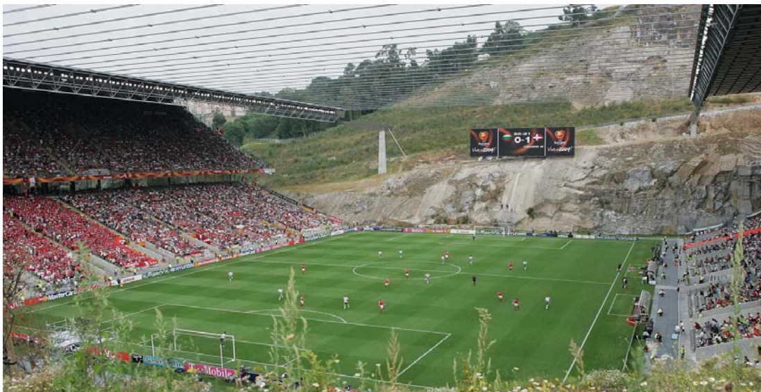
fig. 26 Estádio Municipal de Braga, Braga, Portugal
