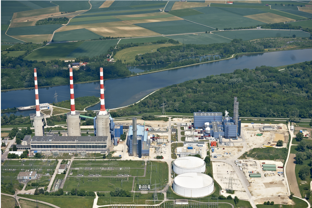
Abbildung 12: Das Kraftwerk Irsching mit Block 4 in der Mitte, (E.ON SE, 2015)
