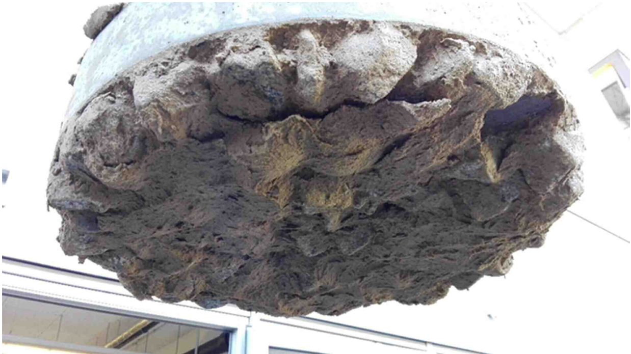
Abb. 59 Ausgebaute UHPC Kopfplatte nach Versuch 2
