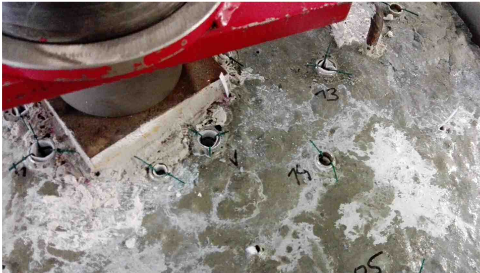
Abb. 44 Eingebaute Schmutzfänger mit dazugehöriger Nummerierung
