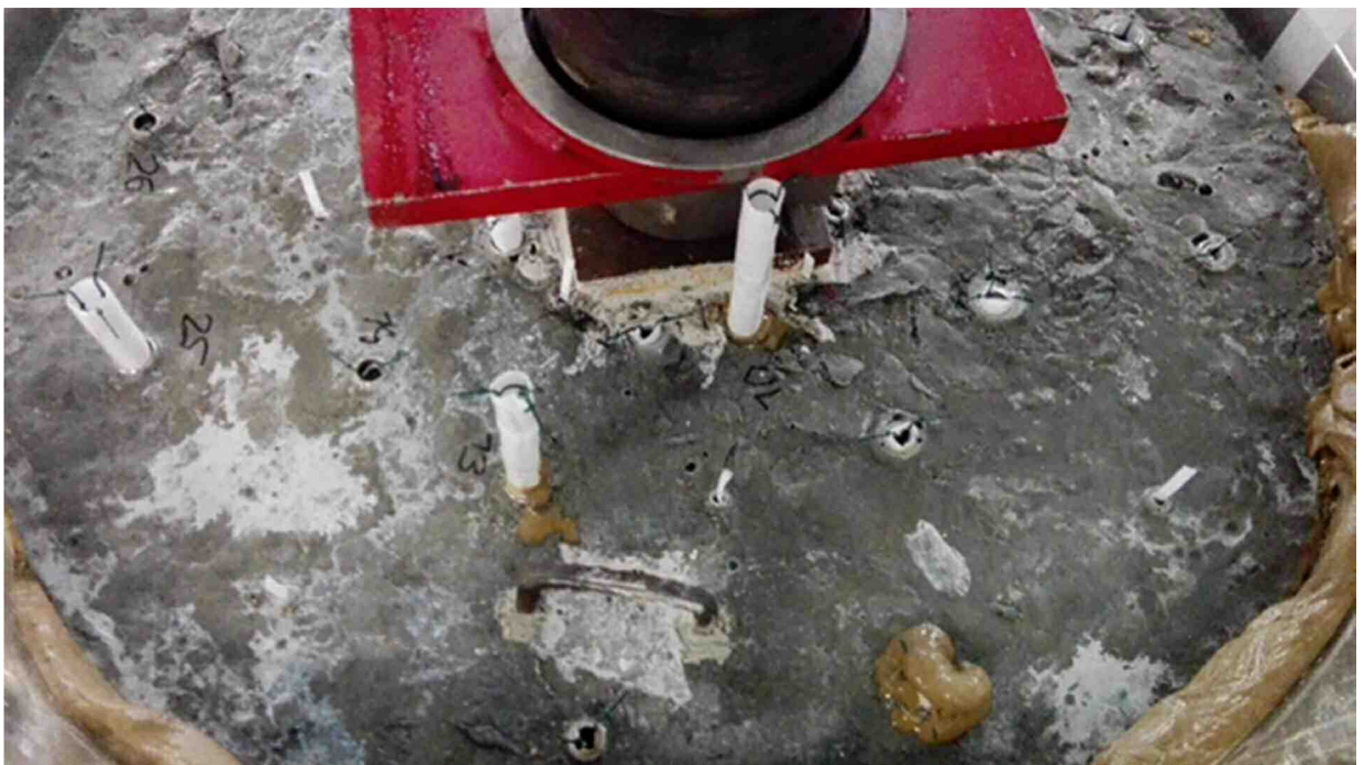
Abb. 57 Ausgedrückte Schmutzfänger während der dynamischen Belastung
