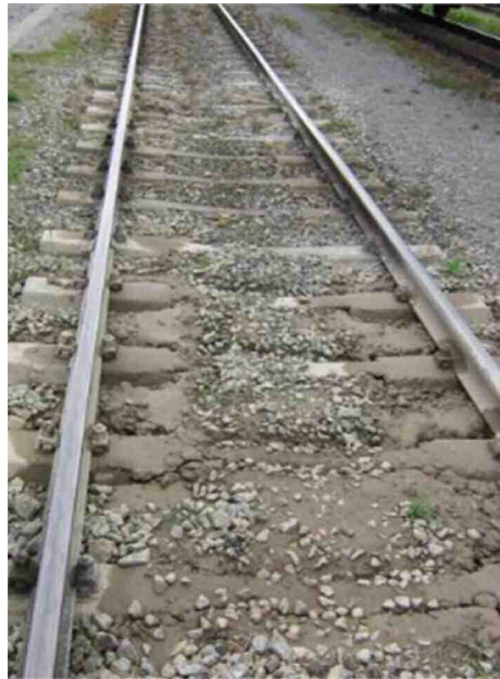
Abb. 2 Beispiel verschlammter Gleiskörper (Quelle: versa.bmvit.gv.at )
