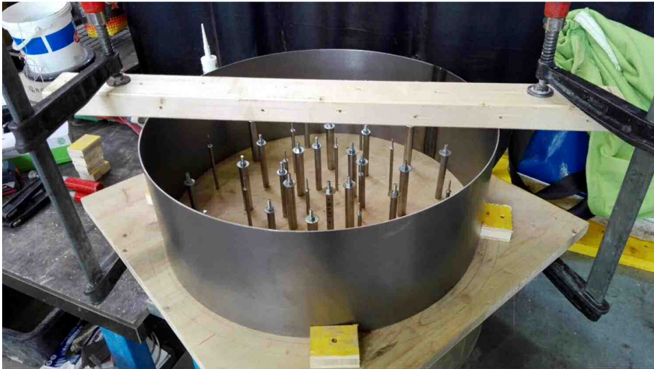
Abb. 27 Fertige Schalung für das Betonieren
