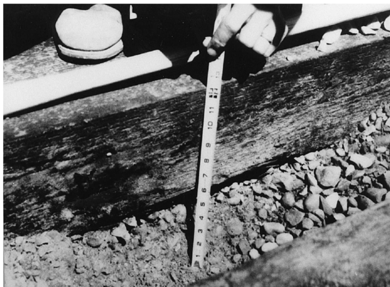
Abb. 5 Beispiel eines verschmutzten Gleisschotters nach einem Winter (Raymond 1999)
