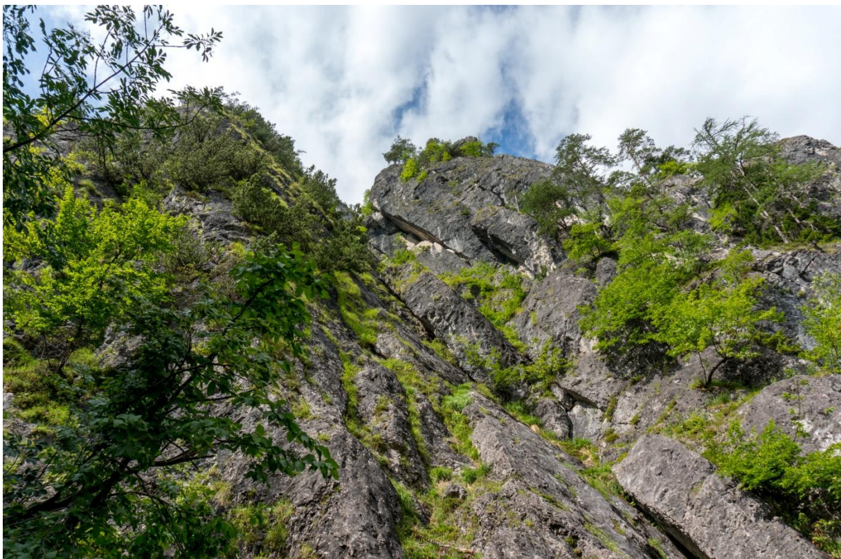
Abbildung 4: Felsaufschluss am westlichen Rand des östlichen Schuttkegels mit Blick Richtung Südwesten
