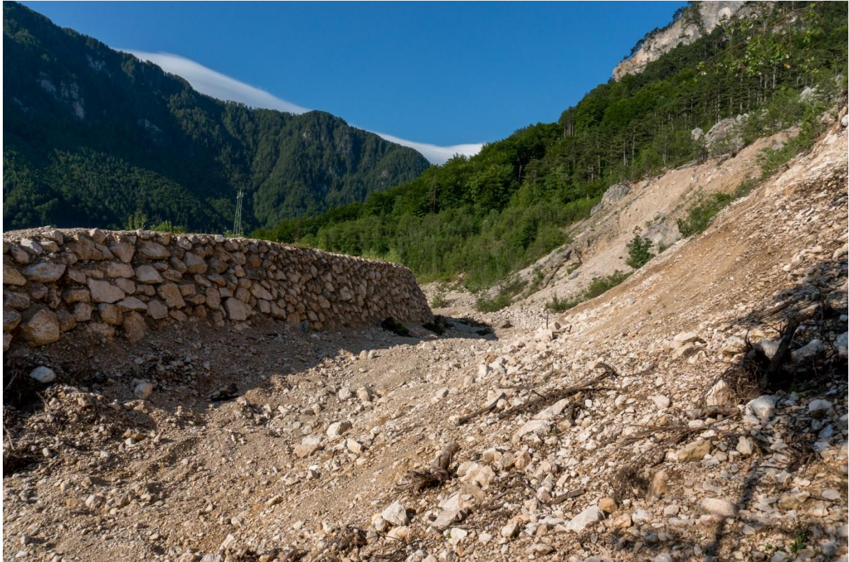
Abbildung 17: Steinschlag - Schutzwall mit Blick Richtung Süden
