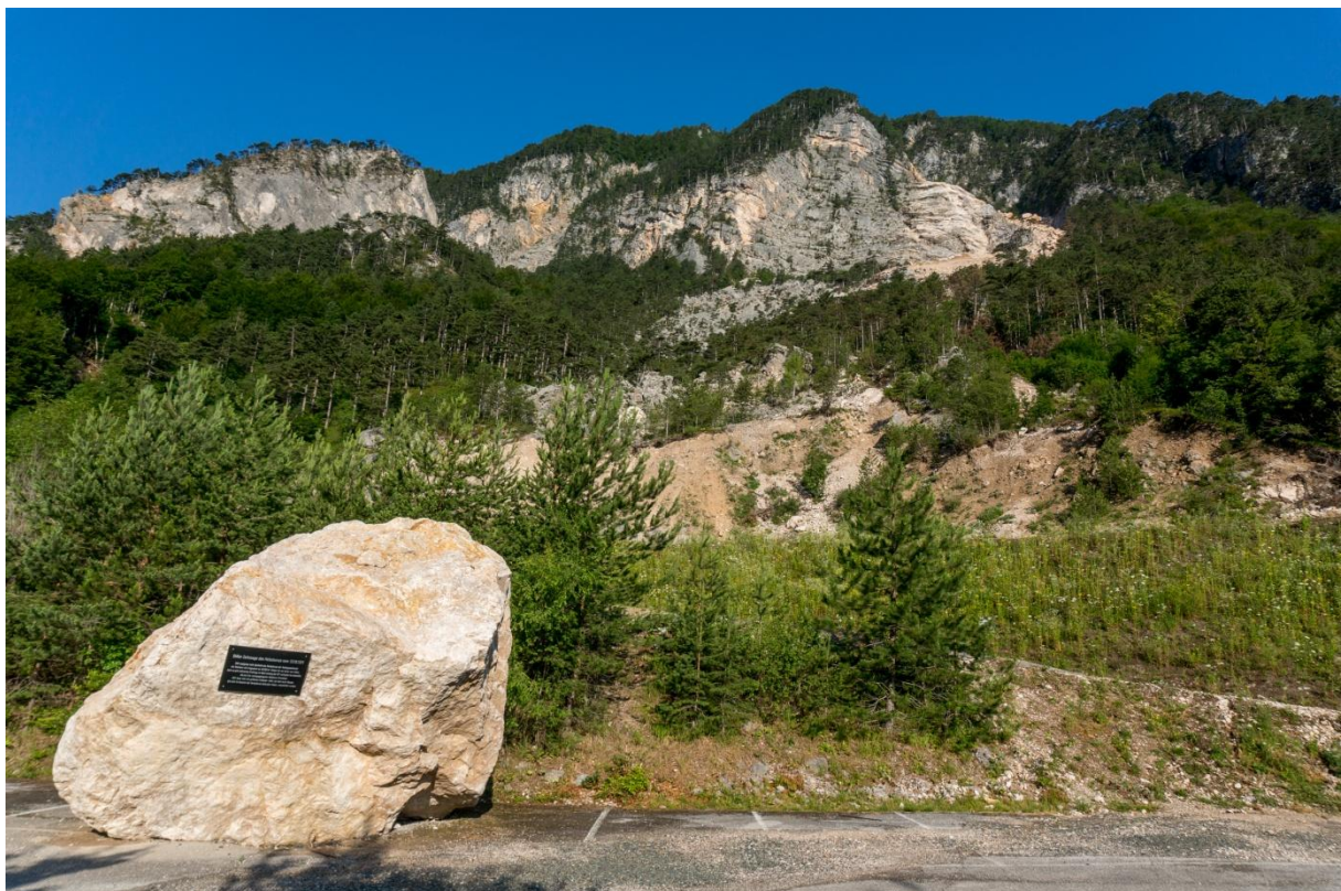
Abbildung 2: Übersicht Gebiet Tschepaschlucht mit Blick Richtung Westen
