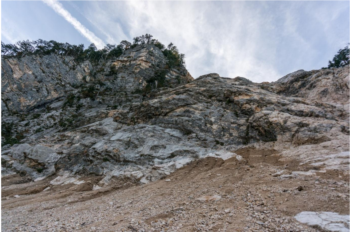
Abbildung 7: Felswand im mittigen Bereich mit Blick Richtung Westen
