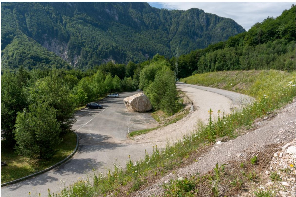
Abbildung 18: Parkplatz hinter Steinschlag - Schutzwall mit stummen Zeugen mit Blick Richtung Süden
