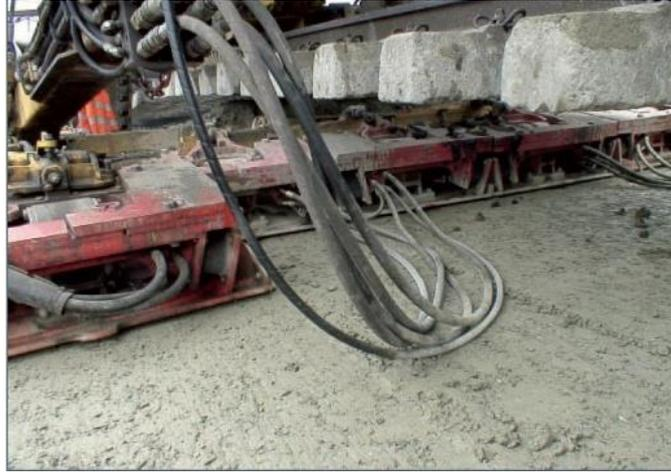
Abbildung 11 Gleichmäßige Plattenverdichtung AHM [Auer, Schilder et al. 2013]
