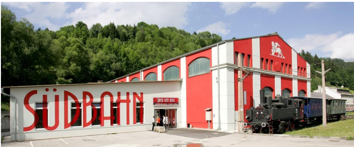
Abbildung 4-58: Außenansicht des SÜDBAHN Museums [100]
