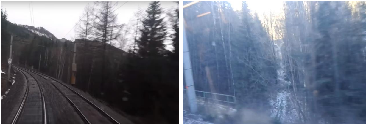
Abbildung 4-74: Aktuelle Situation bei km 99,400 und km 99,100 [121]
