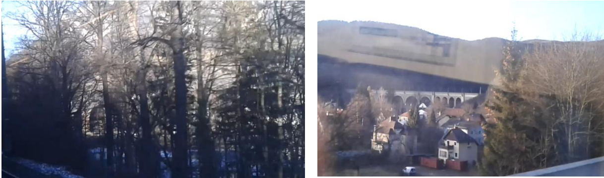
Abbildung 4-79: Bewuchsproblem vor und nach dem Schwarza-Viadukt
