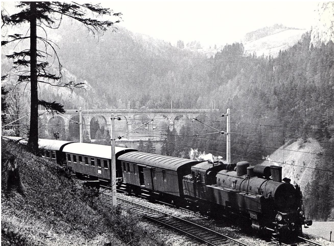
Abbildung 4-72: Blick Kalte Rinne Viadukt bei km 99,550 [46]
