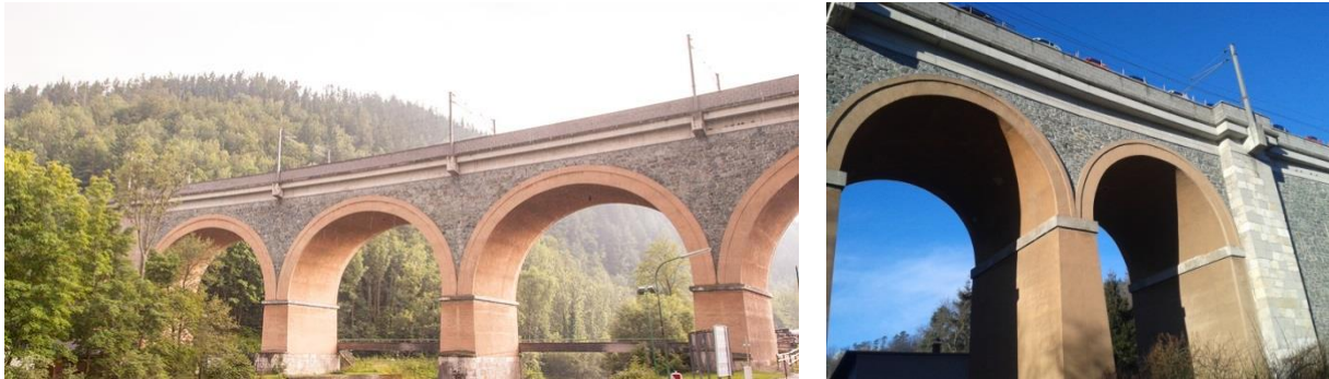
Abbildung 4-86: Das Schwarza Viadukt in Payerbach [123]
