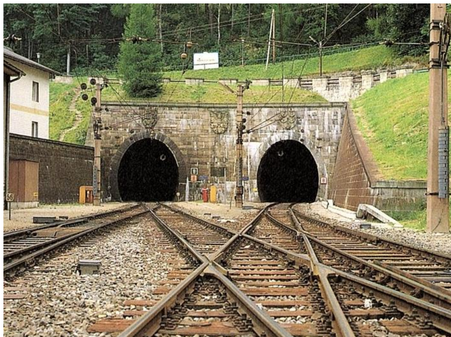
Abbildung 2-11: Nordportal der beiden Scheiteltunnel [20]
