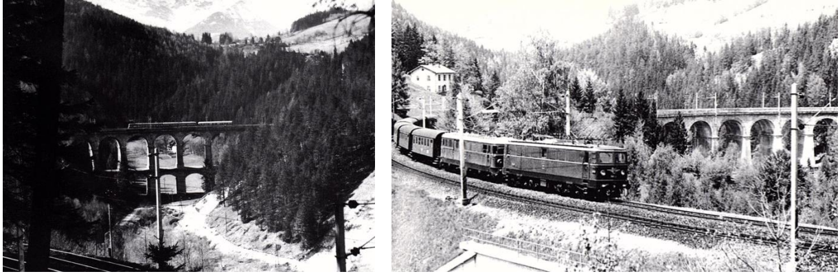
Abbildung 4-73: Blick Kalte Rinne Viadukt bei km 99,400 und km 99,100 [121]
