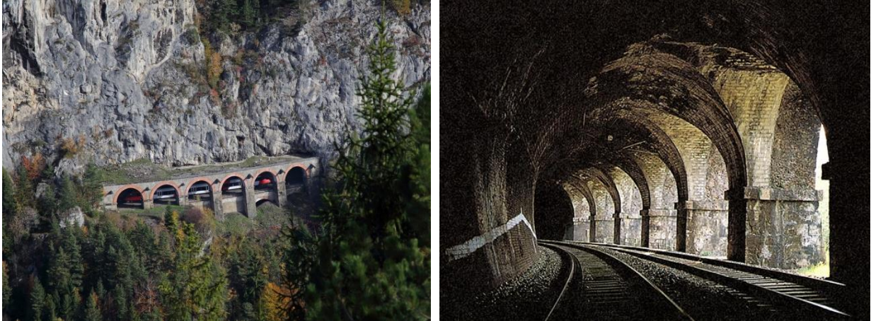
Abbildung 4-75: Weinzettelwandgalerie - Blick von Doppelreiterwarte (links) und die Innenansicht (rechts) [20], [122]
