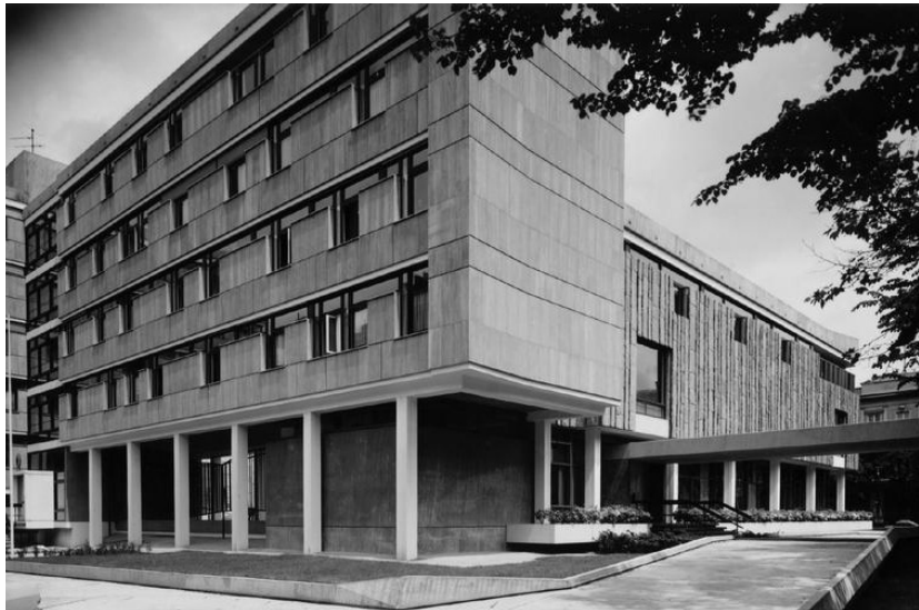
Nachkriegsbau der Deutschen Botschaft vom Architekten Rolf Gutbord in der Metternichgasse 3
