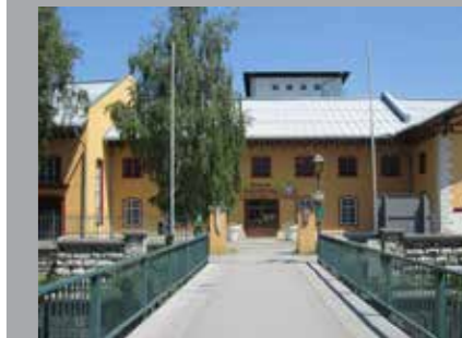
Blick vom Pfannhausersteg auf den Bereich der ehemaligen Salzdarre
