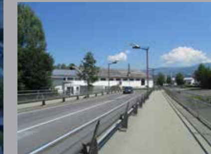
Bundesstraßenbrücke im Norden
