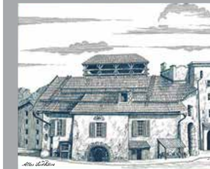
Abb. 37 Frontansicht des alten Sudhauses Raitenau
