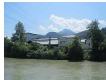
Nordostansicht der Insel mit Trafo
