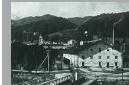
Abb. 94 Ostseite des südlichen Salzmagazins vor 1945
