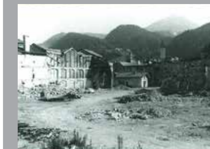
Abb. 99 Abbruch der nördlichen Salinengebäude
