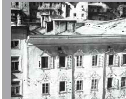
Abb. 24 Gebäude am Kornsteinplatz. Auch die Feuermauern zwischen den Grabendächern sind hochgezogen um Brandüberschlag entgegenzuwirken.
