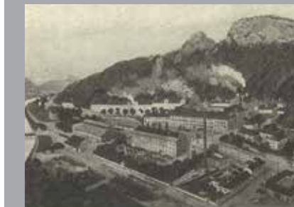
Abb. 73 Das große Areal der Brauerei Kaltenhausen im Norden Halleins
