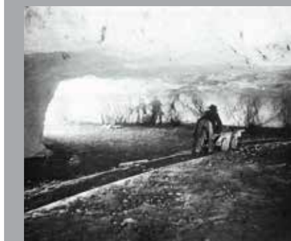
Abb. 42 Aussprengung einer Laugkammer vor Beginn des Laugbetriebes. Um 1910.
