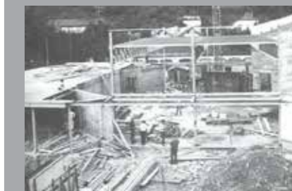
Abb. 109 Bau der Salzberghalle 1972.
