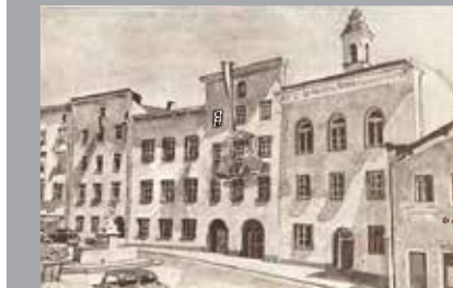
Abb. 22 Hochgezogene Fassaden auch beim Halleiner Rathaus
