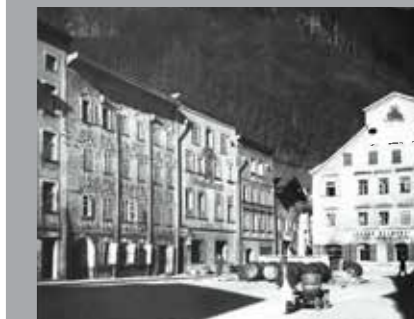
Abb. 23 Kornsteinplatz mit typischer Inn-Salzach-Bauweise. Aufgenommen 1930.
