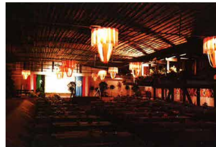
Abb. 100 Die heute alte Sudpfanne als sie sich noch in einem guten Zustand befand. Festlich geschmückt für das Sommerfest des Kiwanis-Cubs. Heute befinden sich an der Stelle der Tische unzählige Holzpeiler, welche die desolante Dachkonstruktion notdürftig stützen.
