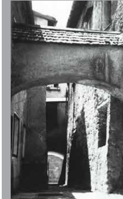
Abb. 27 Schwibbogen - in der Halleiner Altstadt sehr zahlreich. Durch diese können sich Häuser gegenseitig abstützen.
