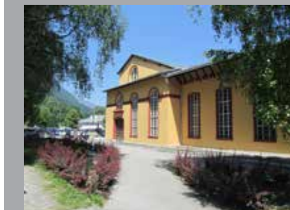
Das Sudhaus im Bereich der Sudpfanne
