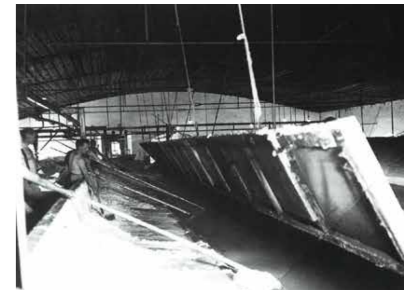
Abb. 55 Ausziehen des Salzes aus einer der vier Sudpfannen in der neuen Saline auf der Pernerinsel. Aufgenommen im Jahre 1930.
