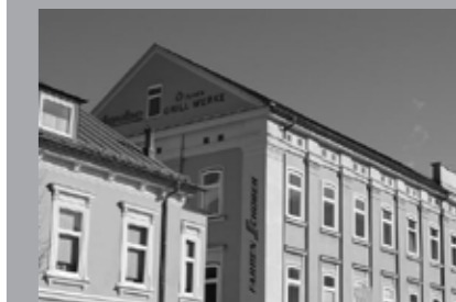
Abb. 75 1939 zogen in das Gebäude der Tabakfabrik die Eugen-Grill-Werke ein. Der größte Rüstungsbetrieb im Land Salzburg hatte ein ausgedehntes Stollensystem für Untertageproduktion.
