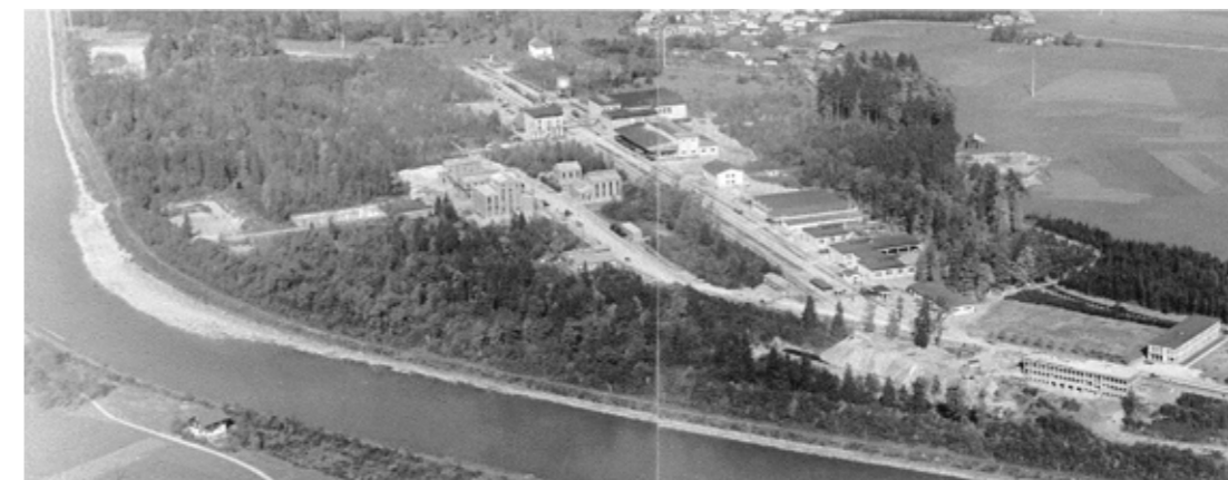
Abb. 80 Luftbild des neuen Solvay-Werks in der Puchhammerau im Jahre 1957
