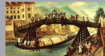
Abb. 52 Abfahrt eines Flussschiffs
