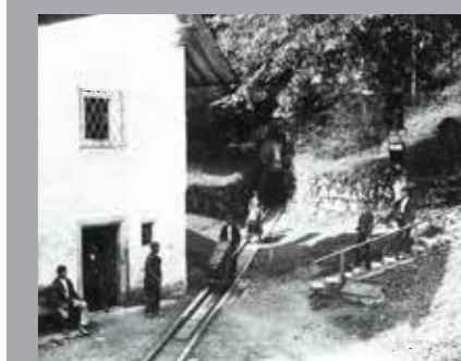
Abb. 43 Wolf-Dietrich-Stollen vor dessen Ausbau im Jahr 1895. Mit in Schienen laufenden Stoßkarren wurde der Grubenschutt abtransportiert.
