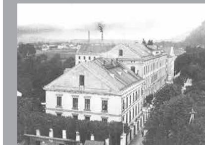
Abb. 74 Die k.k. Tabakfabrik in Burgfried von 1871 bis 1938
