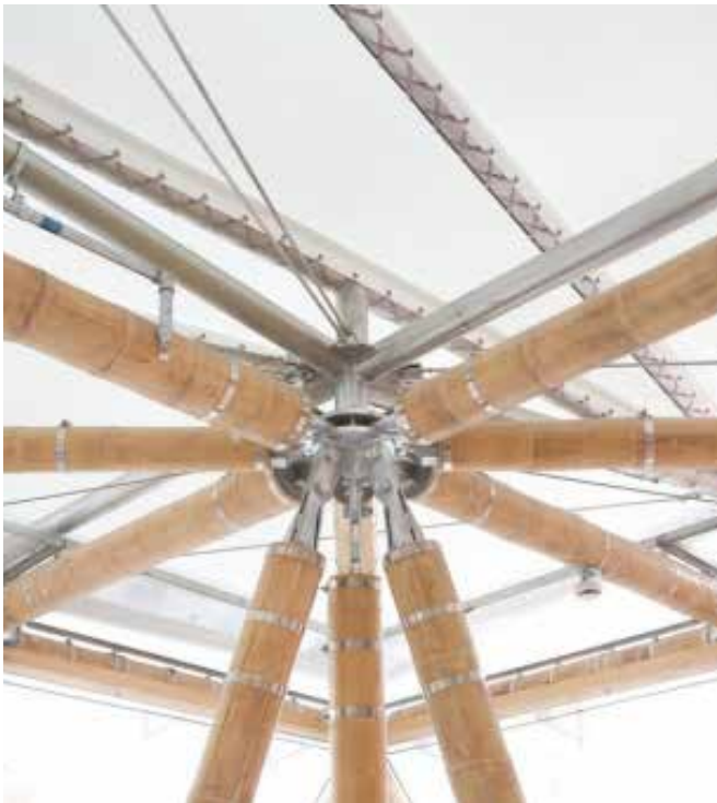
Abb. 18 Detail - Knoten aus Stahl
