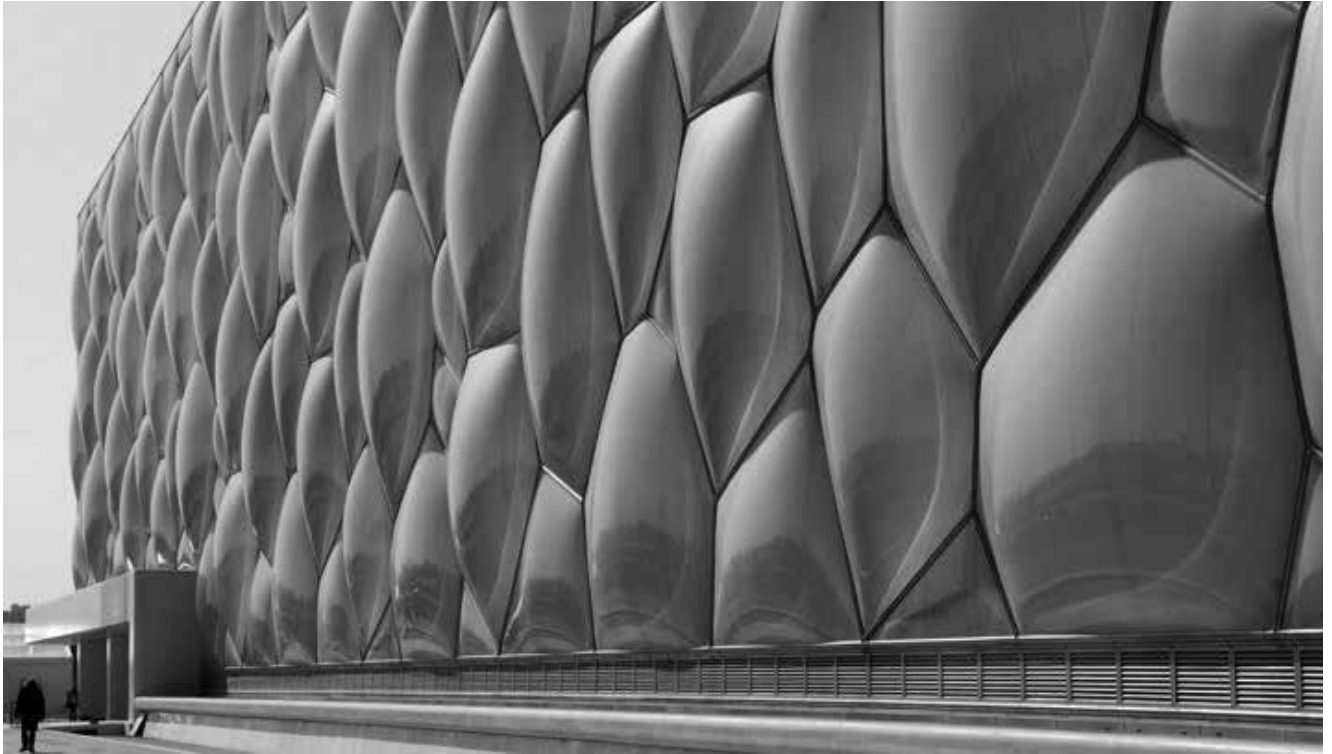
Abb. 11 Watercube - Fassade aus Kissen
