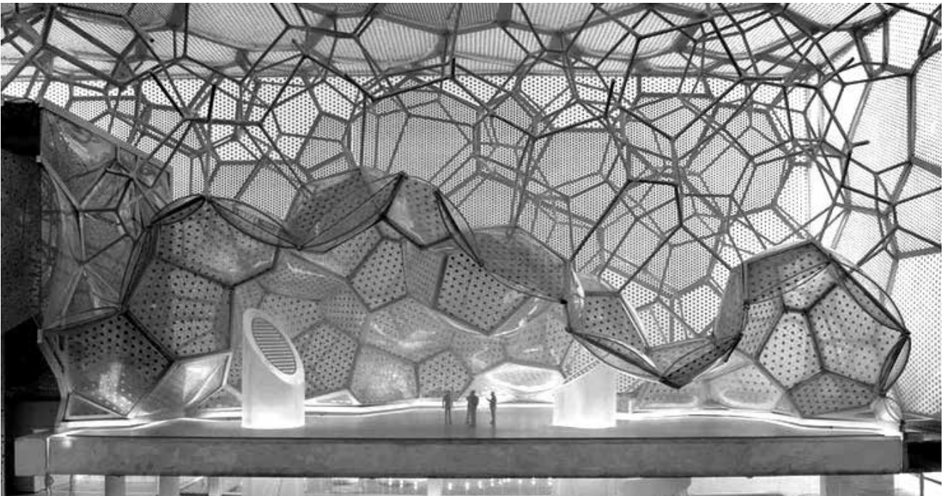
Abb. 12 Stahlkonstruktion und Sonnenschutz
