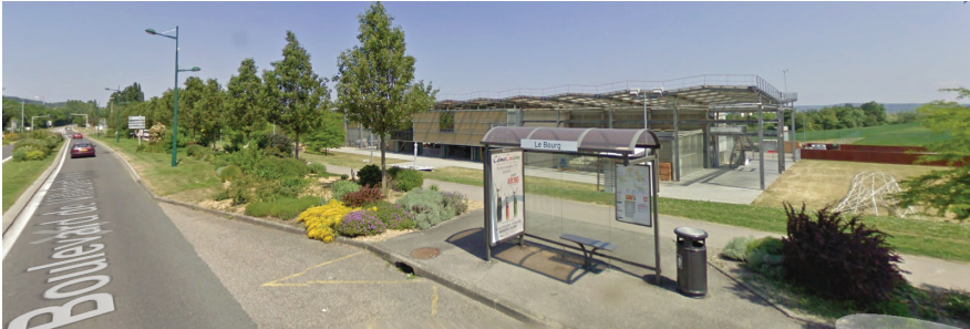
Abb. 4 Ansicht der GAIA vom Boulevard de Villefontaine
