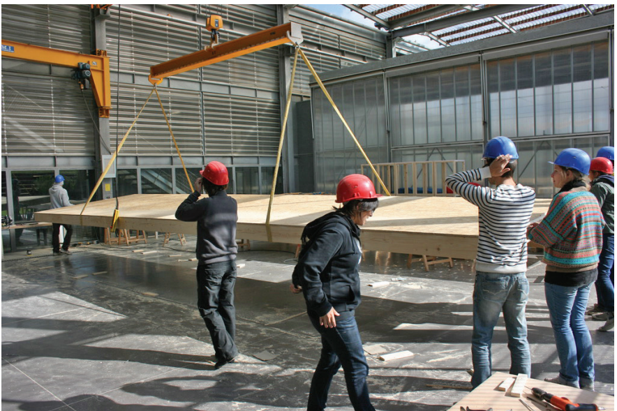
Abb. 26 Modul Holz-Stahl - Heben der schweren Dachkonstruktion (2011)
