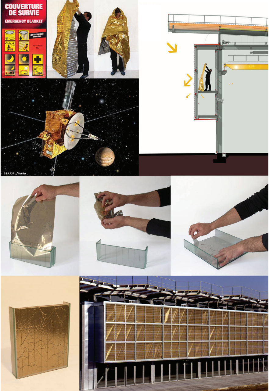
Abb. 13 GAIA - Collage der Fassadenkonstruktion aus Rettungsdecken
