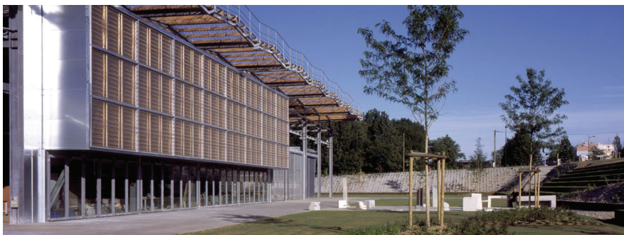
Abb. 15 GAIA – Ansicht aus Nordwesten der Hauptfassade
