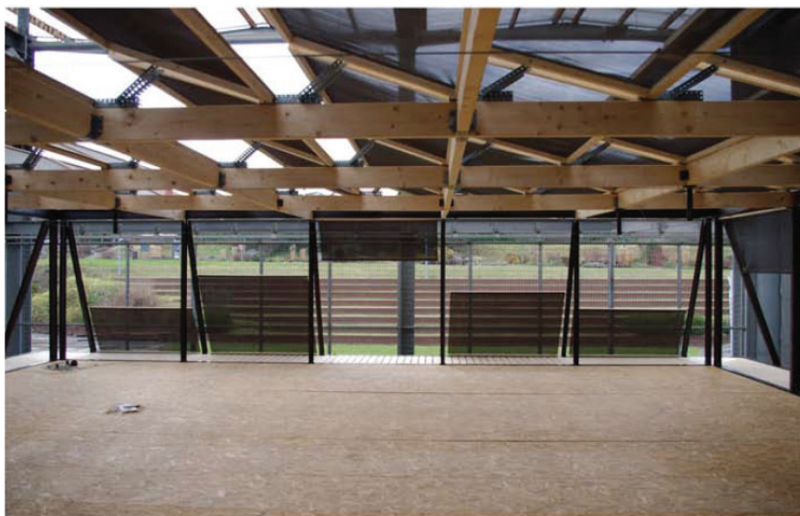
Abb. 30 Blick von Terrasse des Prototyps - Sonnenschutz (2011)
