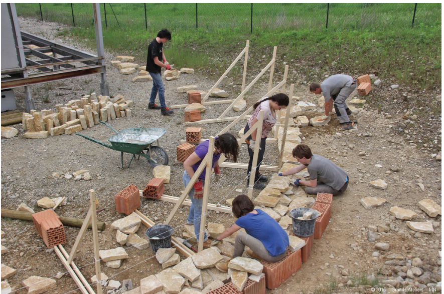
Abb. 18 Konstruktionsübung - Realisierung einer Stützmauer (2015)
