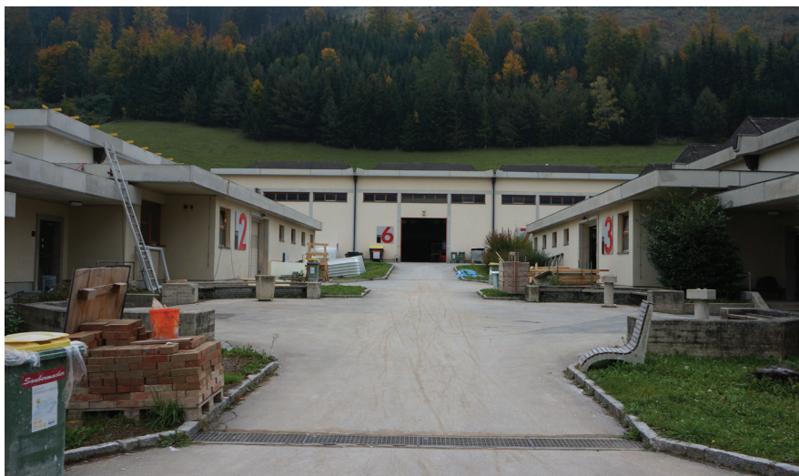
Abb. 54 Die Werkstättengebäude und die Mehrzweckhalle der Bauakademie (2015)
