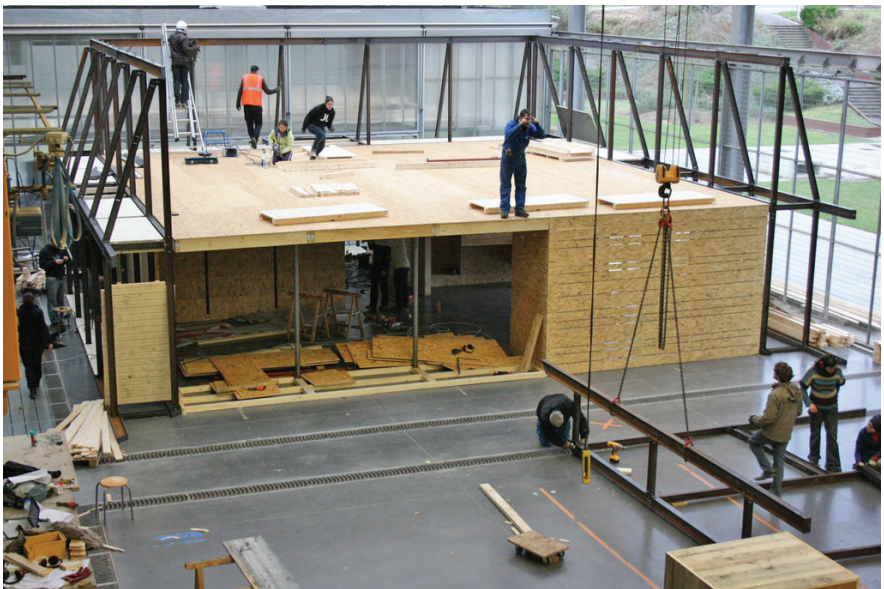
Abb. 32 Bau des Canopea-Protoyps - Die vorgefertigten Stahlelemente werden zusammengesetzt (2011)
