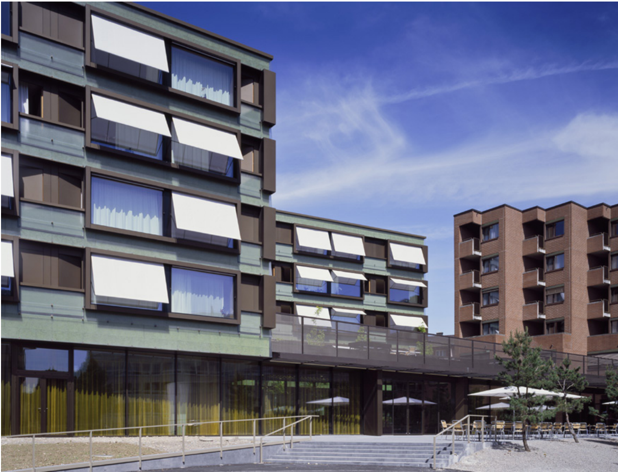
Abb. 56 | Ansicht Alt- und Neubau
