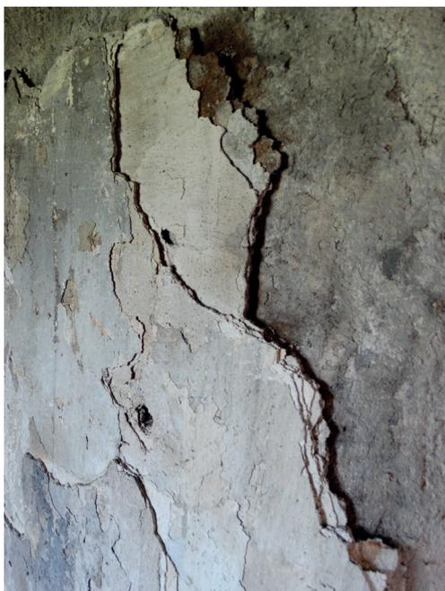
Abb.597. Starke Putzschäden und Putzabplatzungen an allen Aussenmauerwerken
