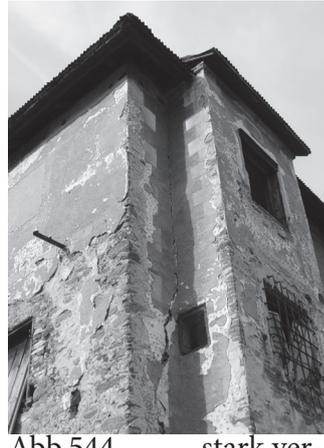
Abb.544. stark verstärkte Putzschäden
