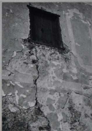
20 Risse im Mauerwerk (durch Sturz und Parapet)
