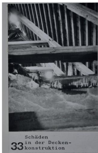
Abb.564. Deckenschäden durch Wassereintritt
