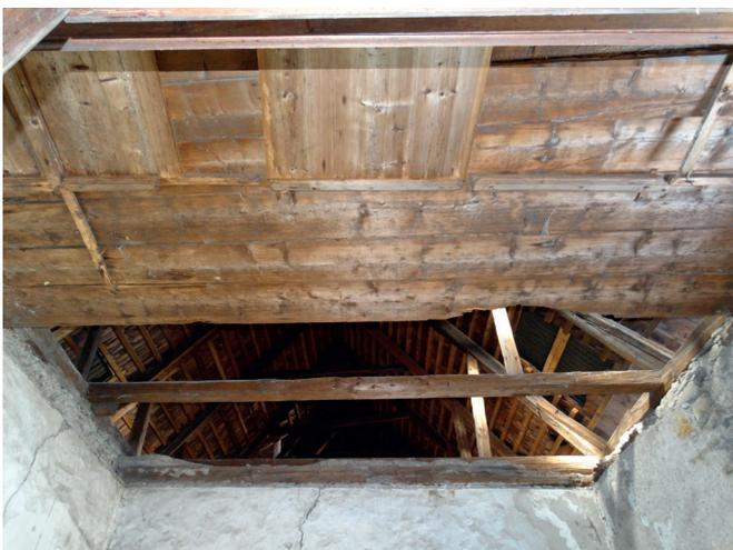
Abb.619. Eingestürzte Decke und stark beschädigte Kassettendecke
