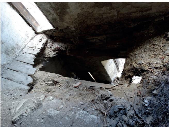
Abb.614. Durch Eindringen von Feuchtigkeit zerstörte Decke
