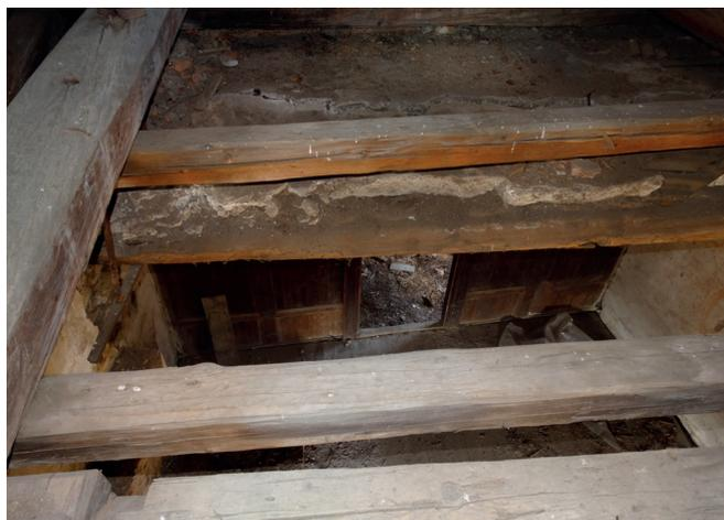
Abb.622. Blick aus dem Dachboden auf die beschädigte Deckenkonstruktion
