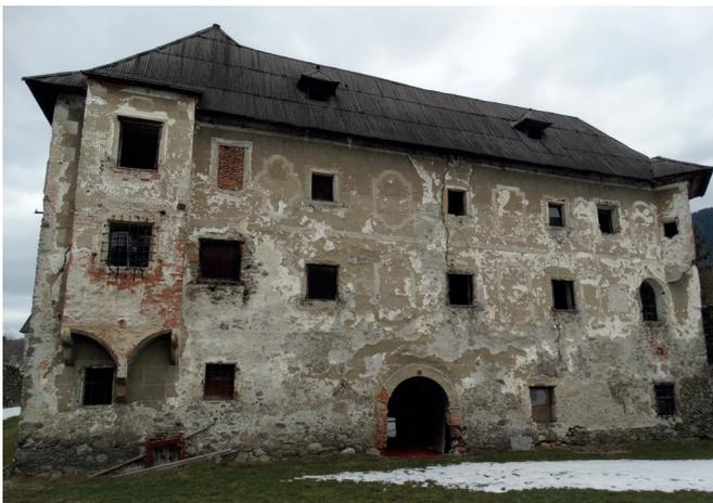
Abb.635. Südansicht mit Putzschäden
