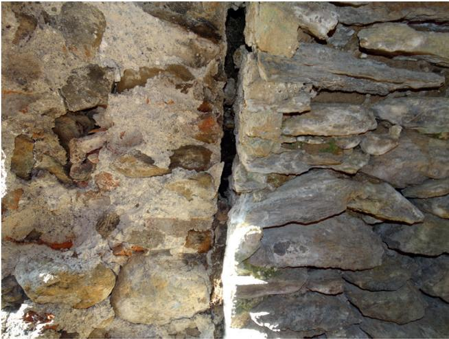
Abb.471. R17 Detail am Eingang - Zweischaliges Mauerwerk
