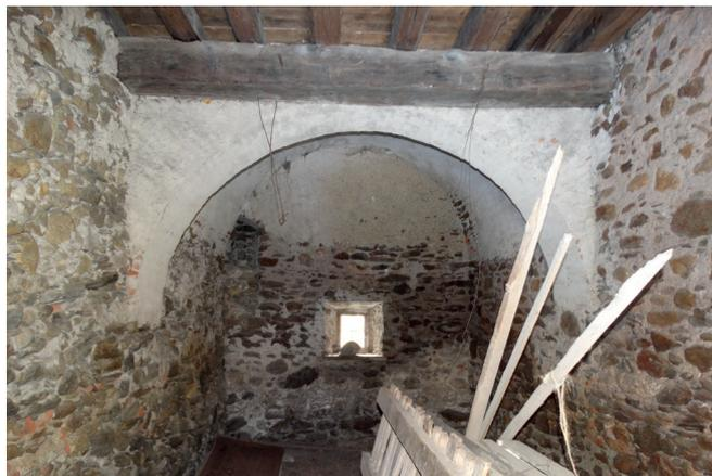
Abb.477. R08 mit sekundärem Gewölbe im hinteren Bereich
