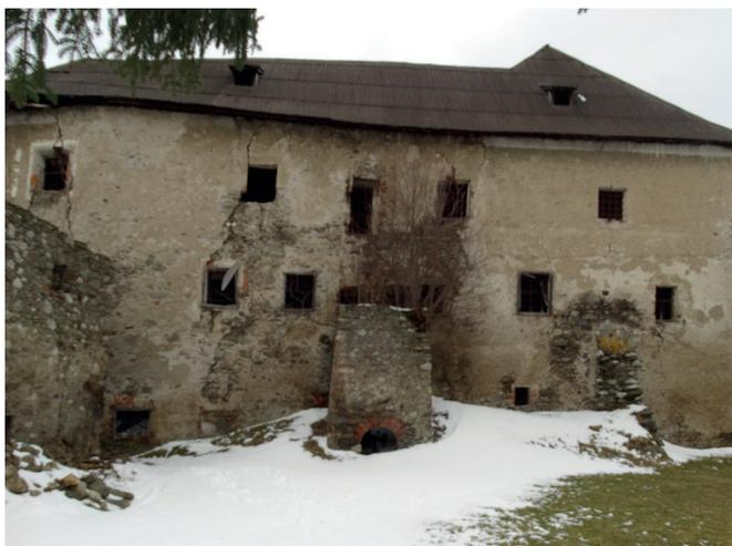
Abb.485. Verbindung zwischen Anbau des vermauerten großen Turmes (rechts) und dem kleinen Turm mit Küche und Kapelle. deutlich sichtbar auch die Richtungswechsel in der Außenmauer
