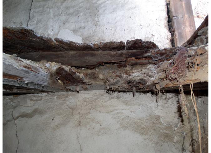
Abb.615. Detail der eingestürzten Decke
