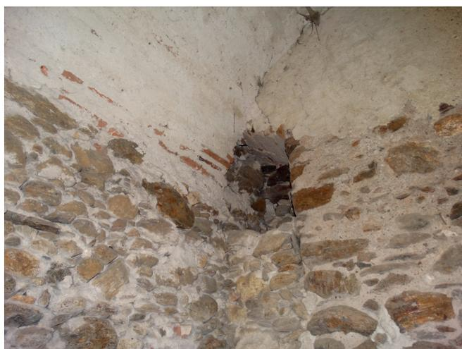
Abb.479. R08 Ecke W1W4 mit vermauerter Öffnung
