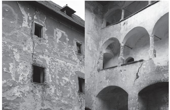
Abb.576. unveränderte Risse, starke Putzschäden
