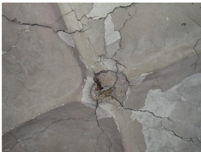
Abb.601. Schäden am Kreuzgewölbe, Putzabplatzungen und Rissbildung
