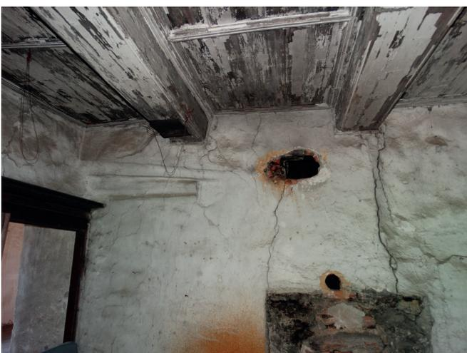
Abb.593. Schäden am Putz und am Mauerwerk durch ein verrostendes Kaminrohr
