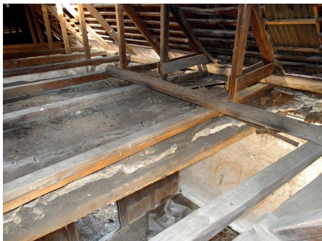
Abb.621. Eingestürzte Decke des Königszimmers - Blick aus dem Dachboden
