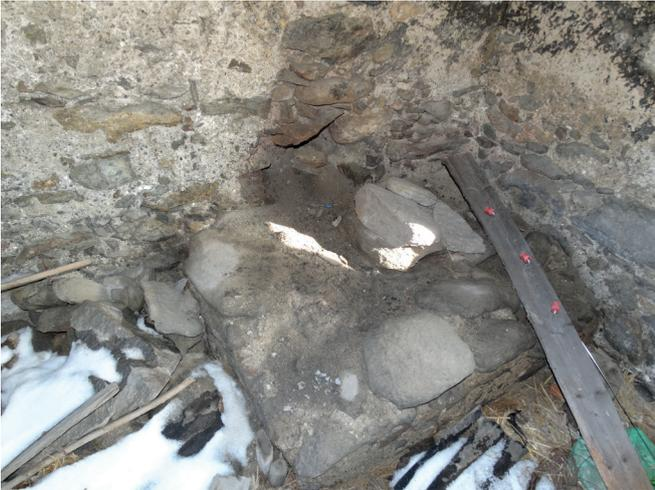
Abb.612. Zerstörte Feuerstelle im Süd-west-Turm
