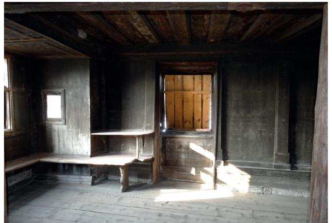
Abb.642. Fensterabdeckungen in den Blockwerkammern
