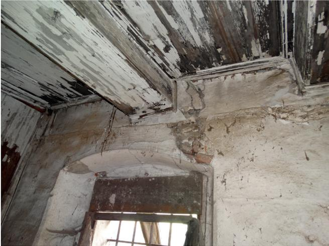
Abb.591. Durch Holzaustrocknung verdrehter Balken
