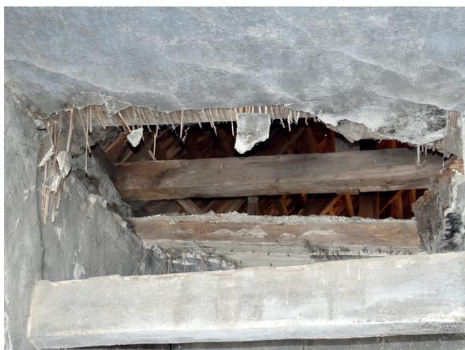
Abb.623. Eingestürzte Decke in der Küche im zweiten Obergeschoss
