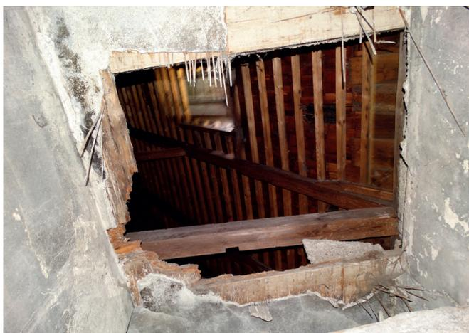
Abb.618. Eine weitere beschädigte Deckenkonstruktion
