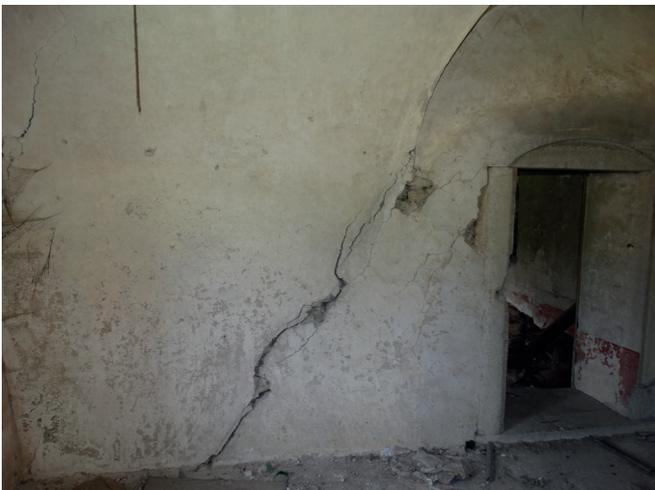
Abb.592. starker Riss im Putz (Mauerwerk)
