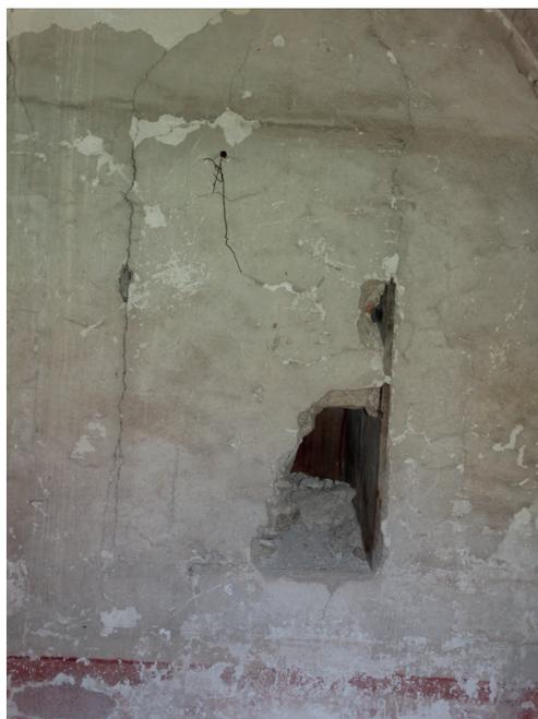
Abb.600. Ausgebrochene Vermauerung einer Wandöffnung
