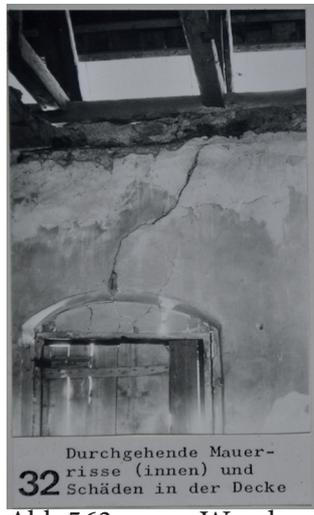
Abb.563. Wand- und Deckenschäden
