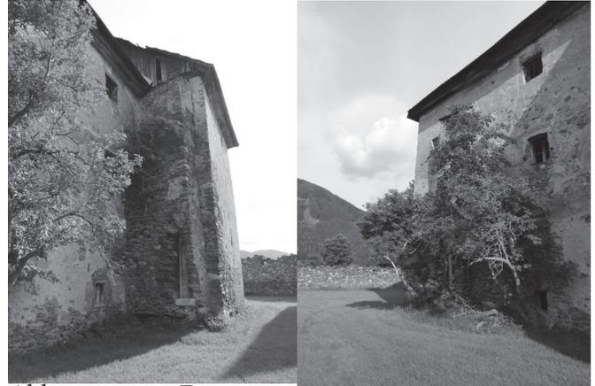
Abb.514. Fortschritt der Schäden am Abtrittserker
