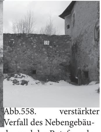
Abb.558. verstärkter Verfall des Nebengebäudes und der Putzfassade
