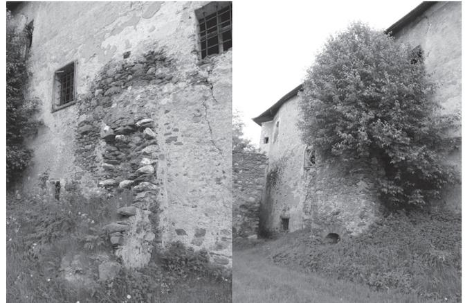
Abb.516. Beinahe unveränderte Schäden an der Stützmauer
