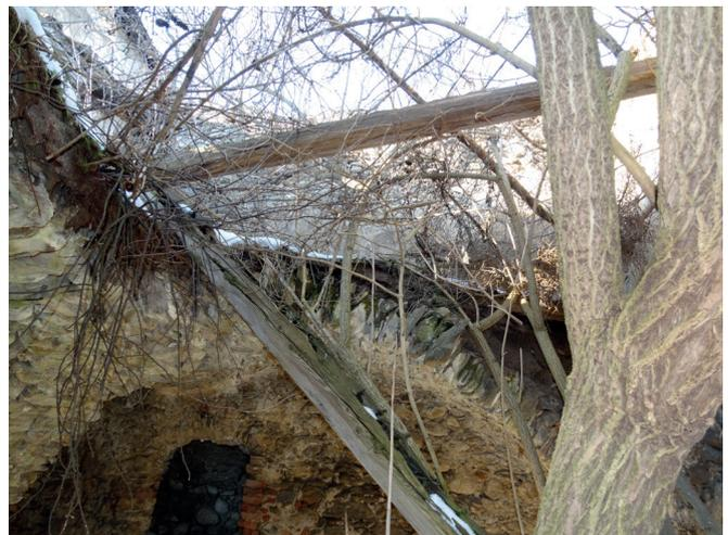
Abb.648. Detail der eingestürzten und bewachsenen Deckenkonstruktion
