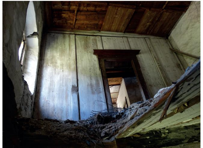
Abb.616. Detailaufnahme der eingestürzten Decke/des eingestürzten Fussbodens
