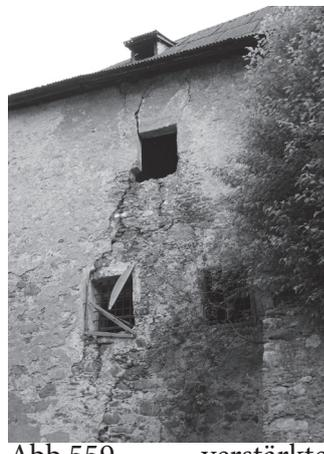
Abb.559. verstärkte Putzschäden
