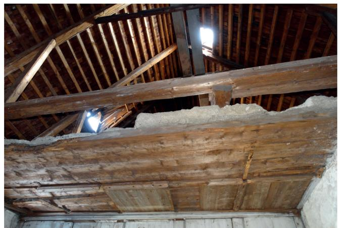
Abb.617. Blick in den Dachboden durch die eingestürzte Decke
