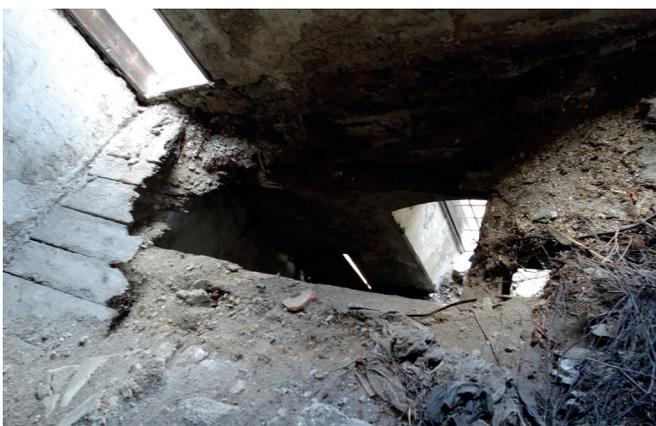
Abb.650. Eingestürzter Fußboden im Raum R37
