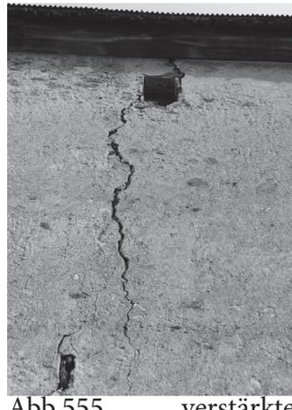
Abb.555. verstärkte Putzschäden
