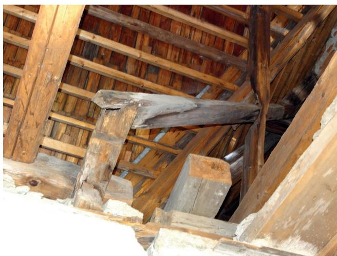
Abb.611. Beschädigte Dachkonstruktion
