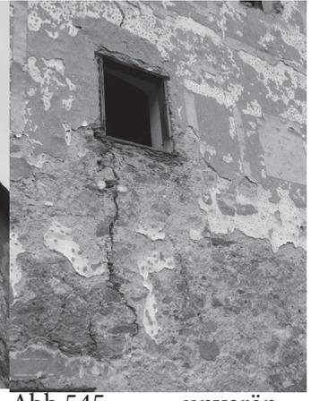
Abb.545. unveränderter Riss, starke Putzschäden
