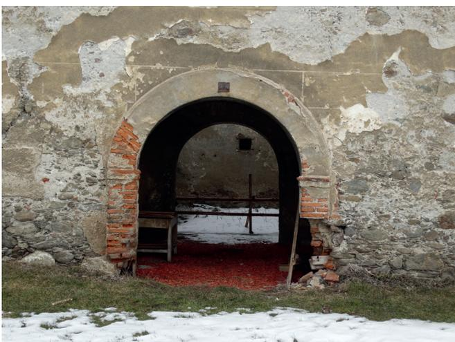
Abb.636. Eingangsportal mit Putz- und teilweise Mauerwerksschäden
