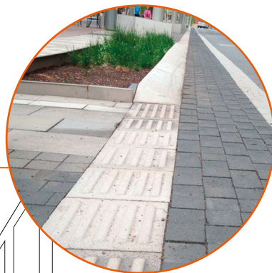
Abb. 39: Taktile Leitsysteme an Übergängen vom Fußgängerbereich zu dem Bereich, in dem mehrere Verkehrsteilnehmer aufeinander treffen, dienen der Sicherheit für sehbehinderte Menschen.
