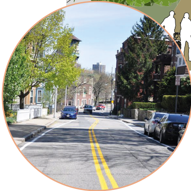
Abb. 44: Durch versetzt, gekennzeichnete Parkplätze wird eine Verschwenkung der Fahrbahn erzeugt. Dadurch wird die Geschwindigkeit des motorisierten Verkehrs „natürlich“ reduziert.
