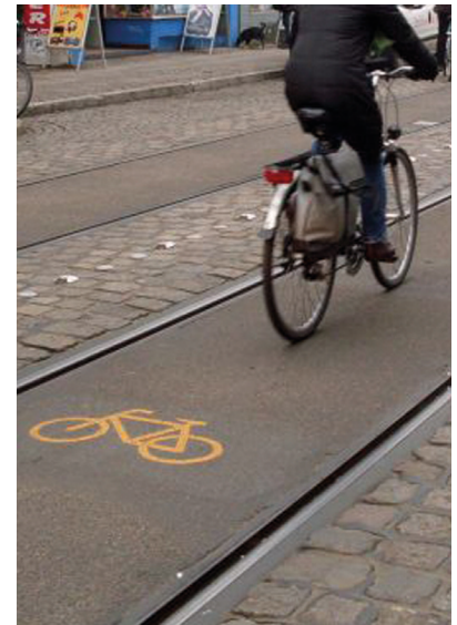
Abb. 15: Kombination von Pflasterung und Asphalt für ein angenehmes Fahrgefühl
