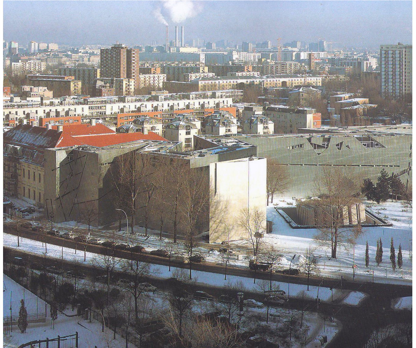
Abb. 66 Blick auf die Lindenstraße. Links das ehemalige Kollegienhaus
