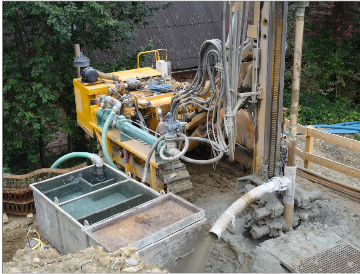
Abbildung 6.2: Austrag des Bohrgutes beim Lufthebeverfahren 204
