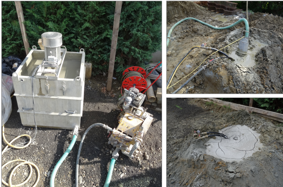
Abbildung 6.5: Veranschaulichung des Verpressvorgangs 207
