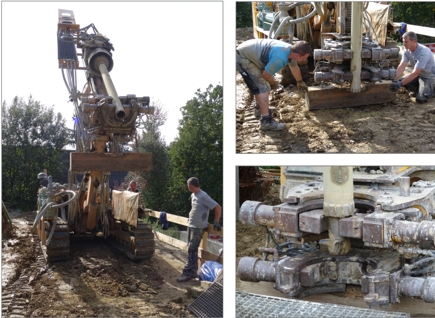
Abbildung 6.1: Aufstellen und einrichten des Bohrgeräts 203
