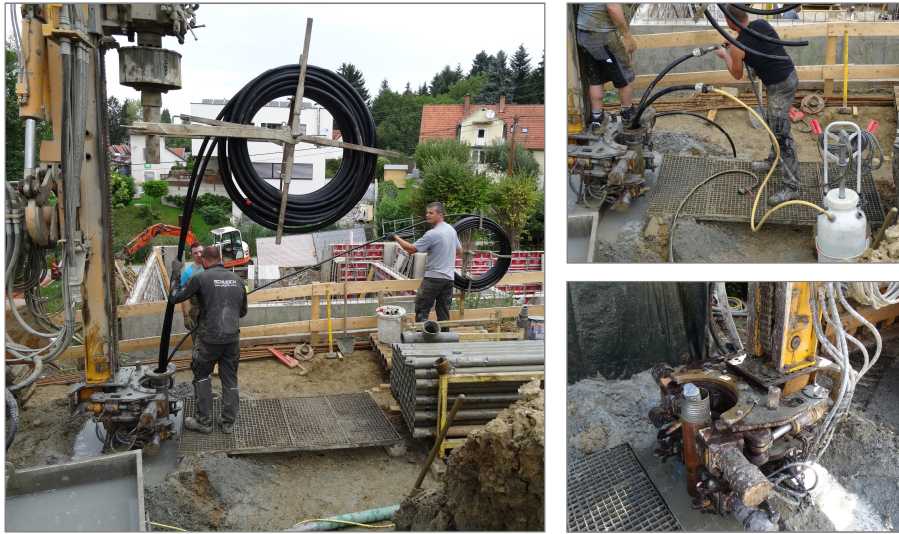
Abbildung 6.4: Einbringen der Sonde mit Hilfe einer Haspel 206
