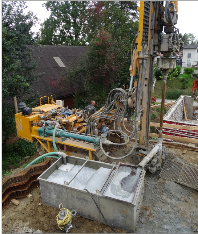
Abbildung 6.3: Austrag des Bohrgutes beim Spülbohrverfahren 205
