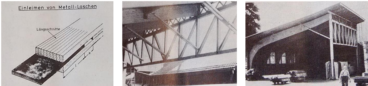
Abbildung 5.1: geschlitztes Furnierschichtholz (links) und Fachwerk mit eingeklebten Stahllaschen (Mitte und rechts) [76]
