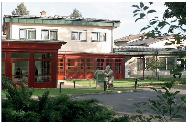
Abb. 31: Aktuelle Ansicht des Innenhos mit den Werkstätten
