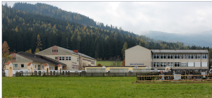
Abb. 21: Friedhof mit dahinter liegendem Schulgelände (links Volksschule, rechts NMS)
