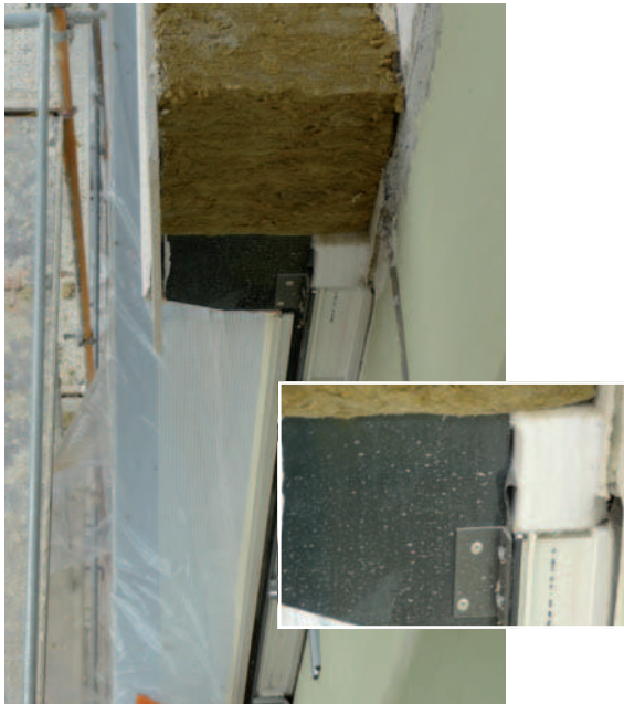
Anschlussdetail Rolladenkasten/Fassade gedämmt mit 5-lagig Aerogel Ausführender: Firma Emter, Freiburg
