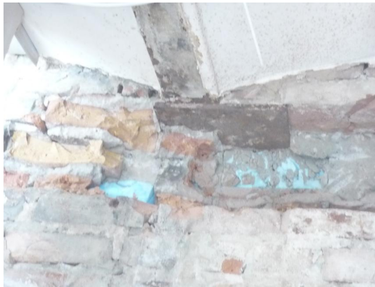
Abbildung 23 - aufgestemmtes Auflager eines Stahlträgers einer Kappendecke am Bauvorhaben Stadthöfe Hamburg, lastverteilende Stahlplatte
