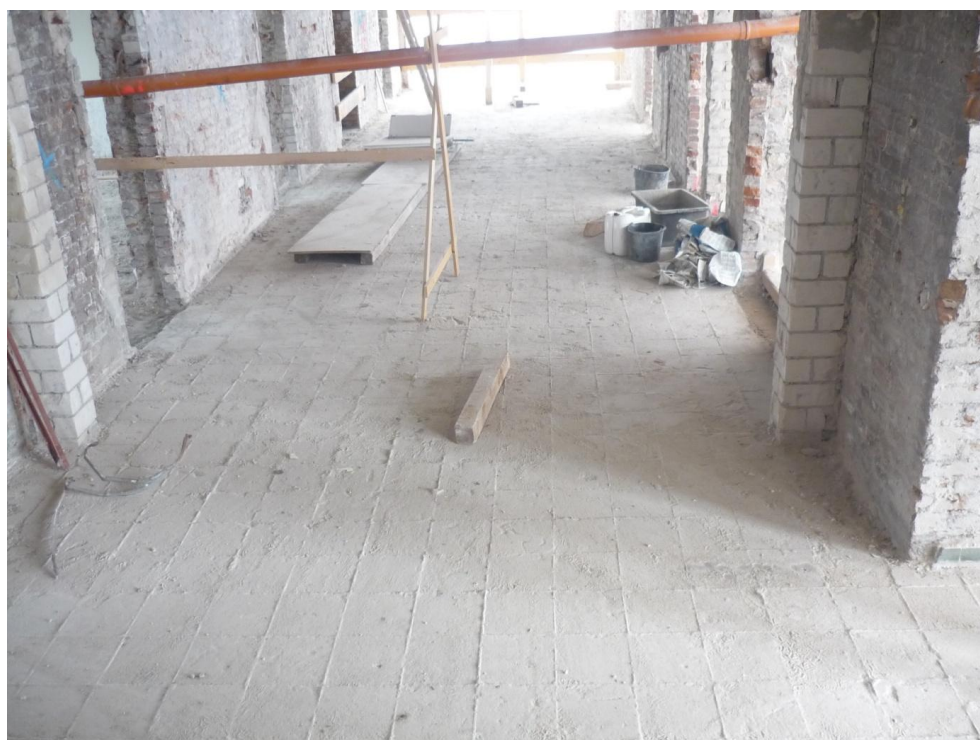
Abbildung 33 - freigelegte Betondruckplatte, System 3
