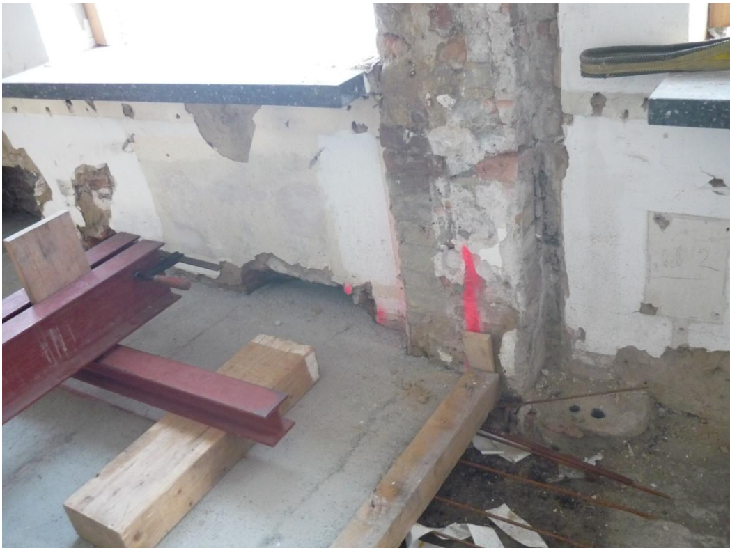
Abbildung 47 - Auflagertasche LC-Betondruckplatte, 3.OG
