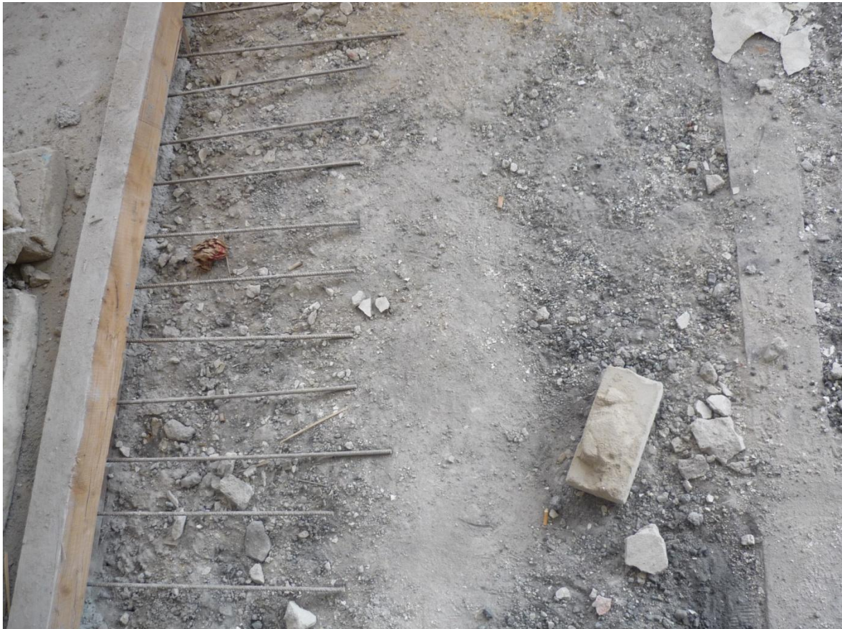
Abbildung 34 - System 1, neu hergestellte LC-Betonplatte mit Anschlussbewehrung (links), Kappenrücken, Schlackenverfüllung und Walzprofil-Oberflansch
