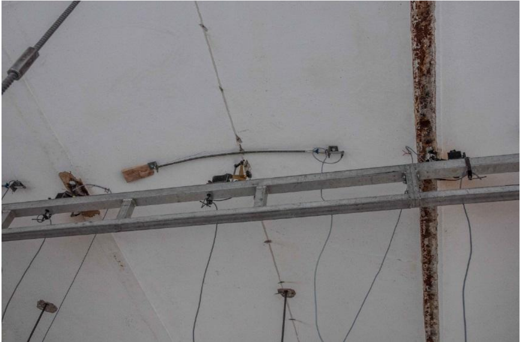
Abbildung 44 - Wegaufnehmer am Gewölbe, D. ü. 2.OG
