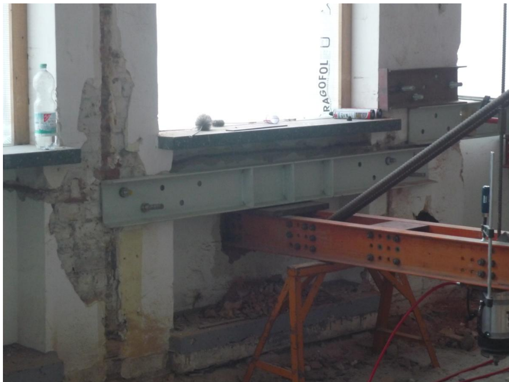
Abbildung 43 - Widerlagerung der Belastungsrahmen am Bestand, 1.OG
