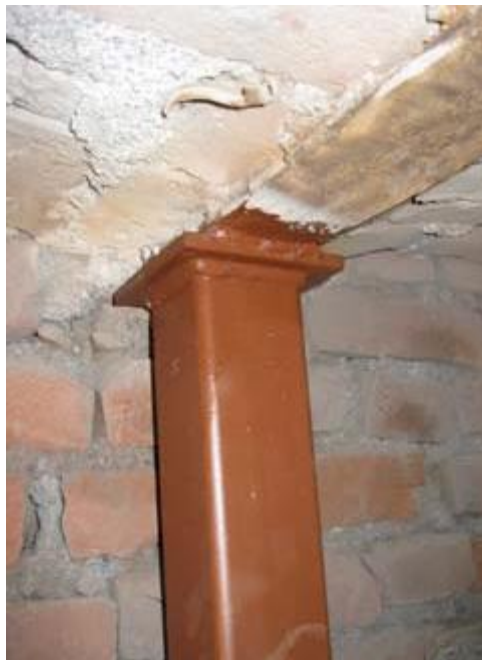
Abbildung 25 - Neue innenliegende Stützung eines Kappendeckenträgers [19]
