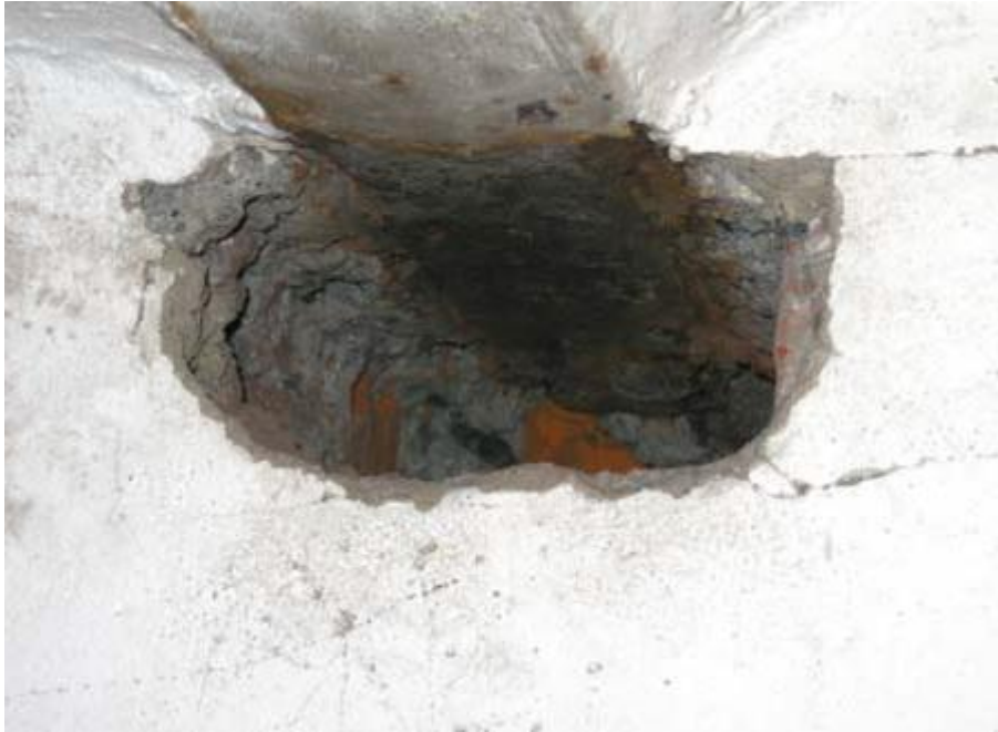
Abbildung 24 - Korrodiertes Trägerauflager [19]
