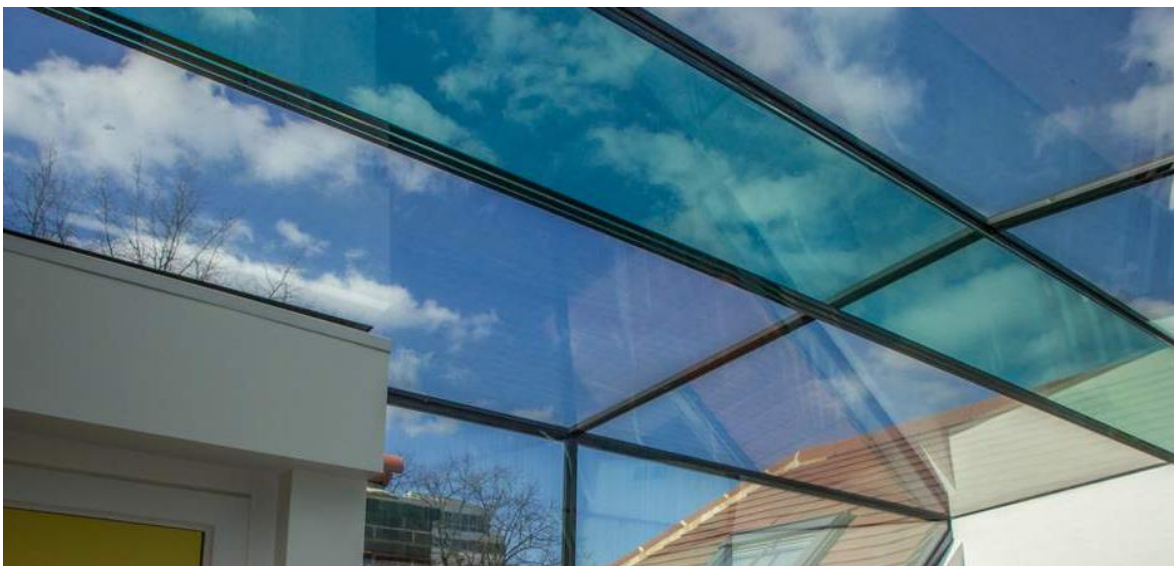
Abb. 5-2 Dreischichtiger VSG aus TVG Glasträger (Arnold House School in north London) {6}
