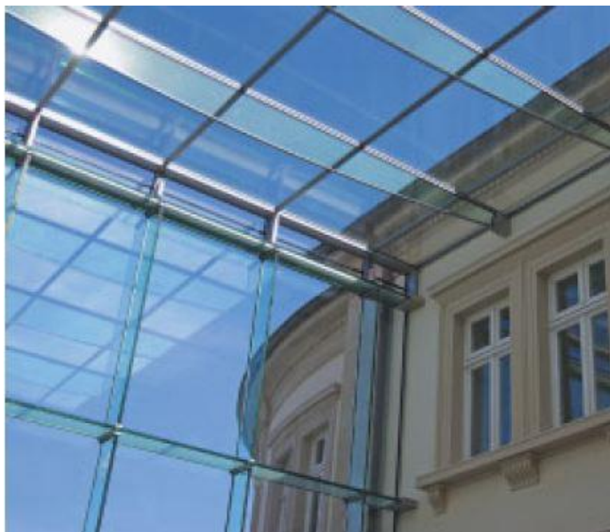
Abb. 7-1 Spannlasträger in Dachkonstruktion [20]
