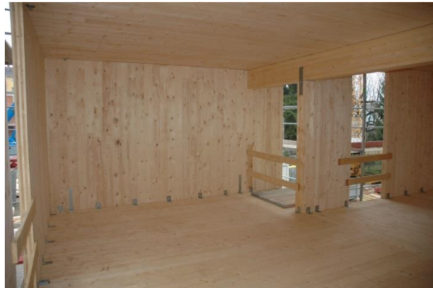
Abbildung 4.12: massive living Anordnung der BSP-Elemente, aus (Zimmer, 2013)
