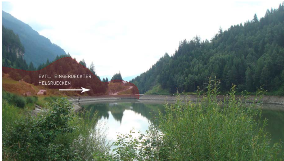
Abb. 3 Talverengung durch eventuell eingerückten Felsrücken
