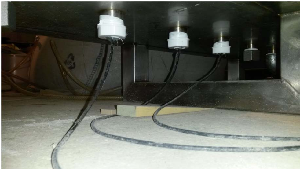
Abb. 55 Installation der Mini-Piezometer in der Versuchsbox
