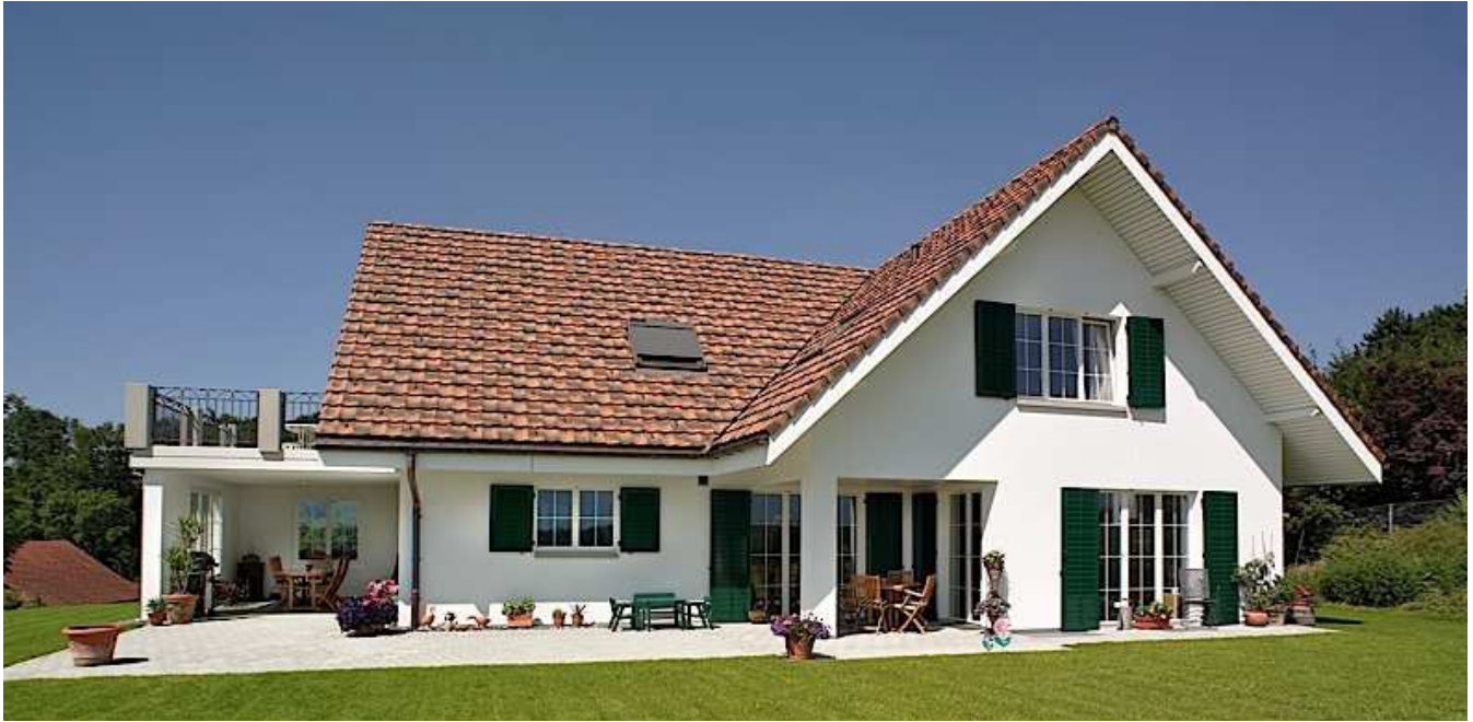
Abb.03 - Beispiel für das typische Einfamilienhaus
