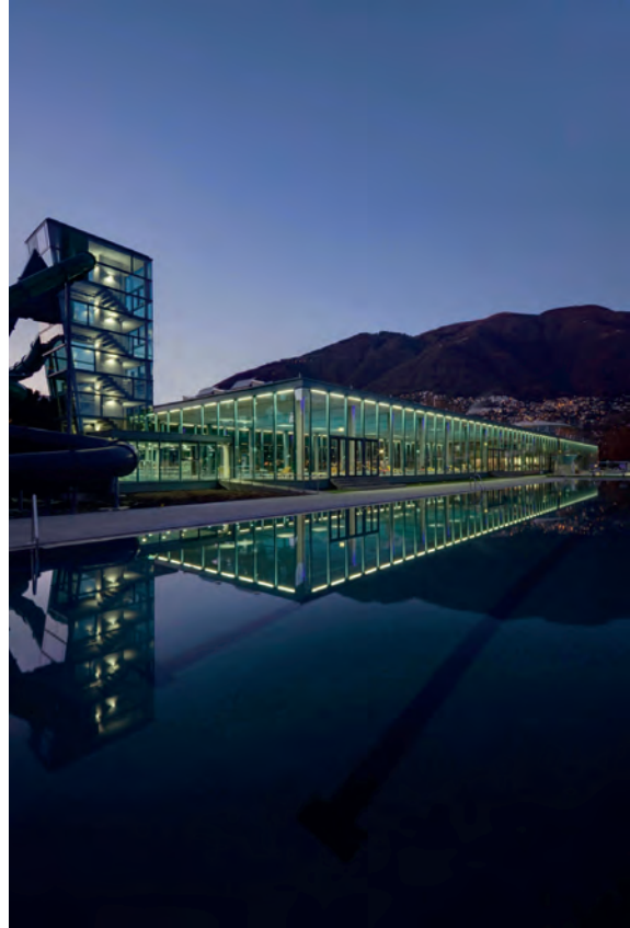
Abb.37 Fassade bei Nacht Autor: Moro e Moro
