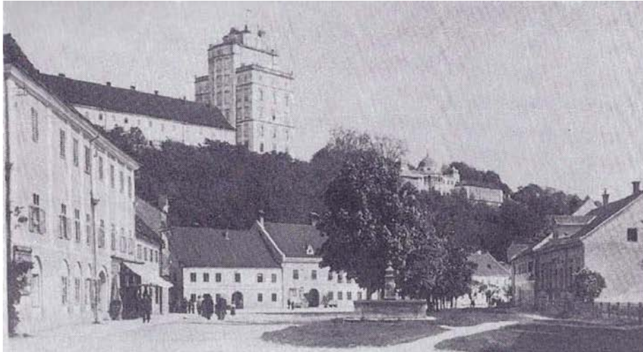
Abb. 06: Alte Ansicht des Marktplatzes von Süden
