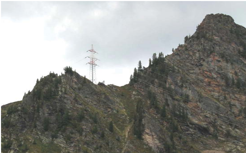
Abb. 64: Beispiel einer Mastexposition - Mast 37 in Abschnitt 4 der HGL
