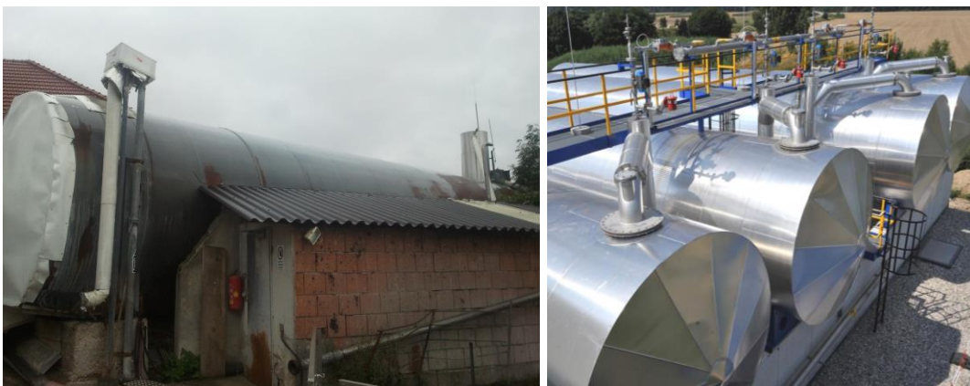
Abbildung 20 Horizontalfermenter – Selbstbau aus dem Jahr 1992 (links) und high-tech Anlage aus dem Jahr 2009 (rechts)
