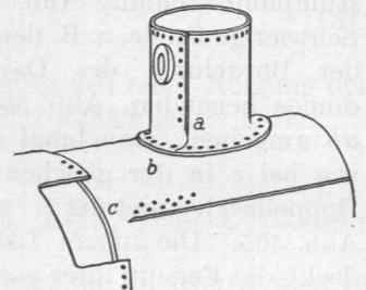
Abb. 504. Dampfessel mit Schweißstellen bei a—b und c.
