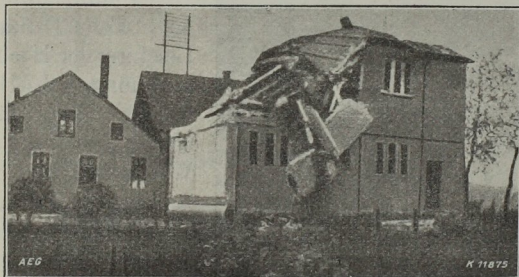
Durch Explosion von Ölgasen zerstörtes Transformatorhaus
