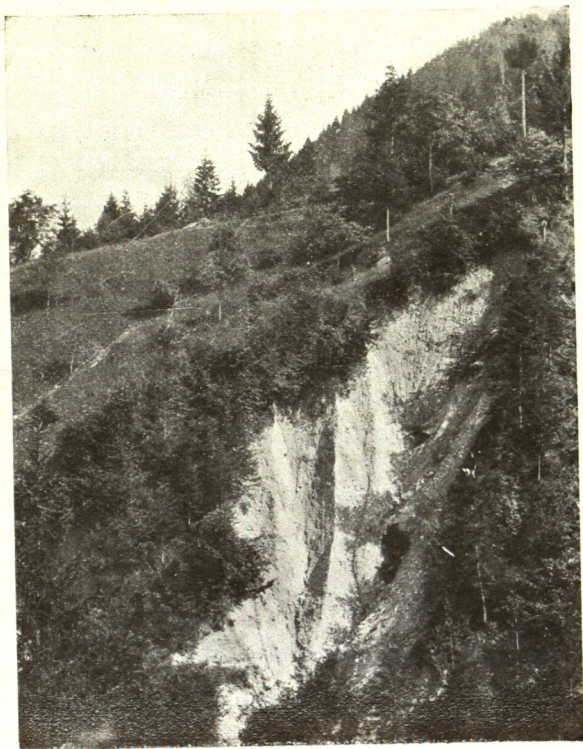
Tav. 41. — Frana sopra Valgrande — Prima della correzione. (Prov. di Belluno). —
