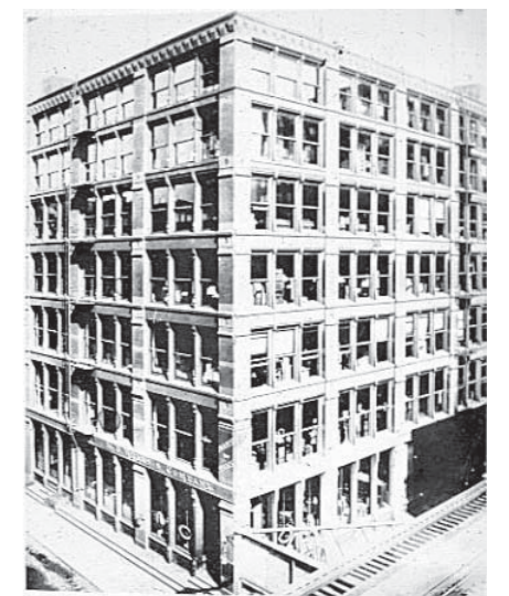
Abb.2 First Leiter Building in Chicago, Illinois. Architekt: William LeBaron Jenney, 1879. Freier Grundriss, durch 15 Gusseisensäulen (Abb.1)
