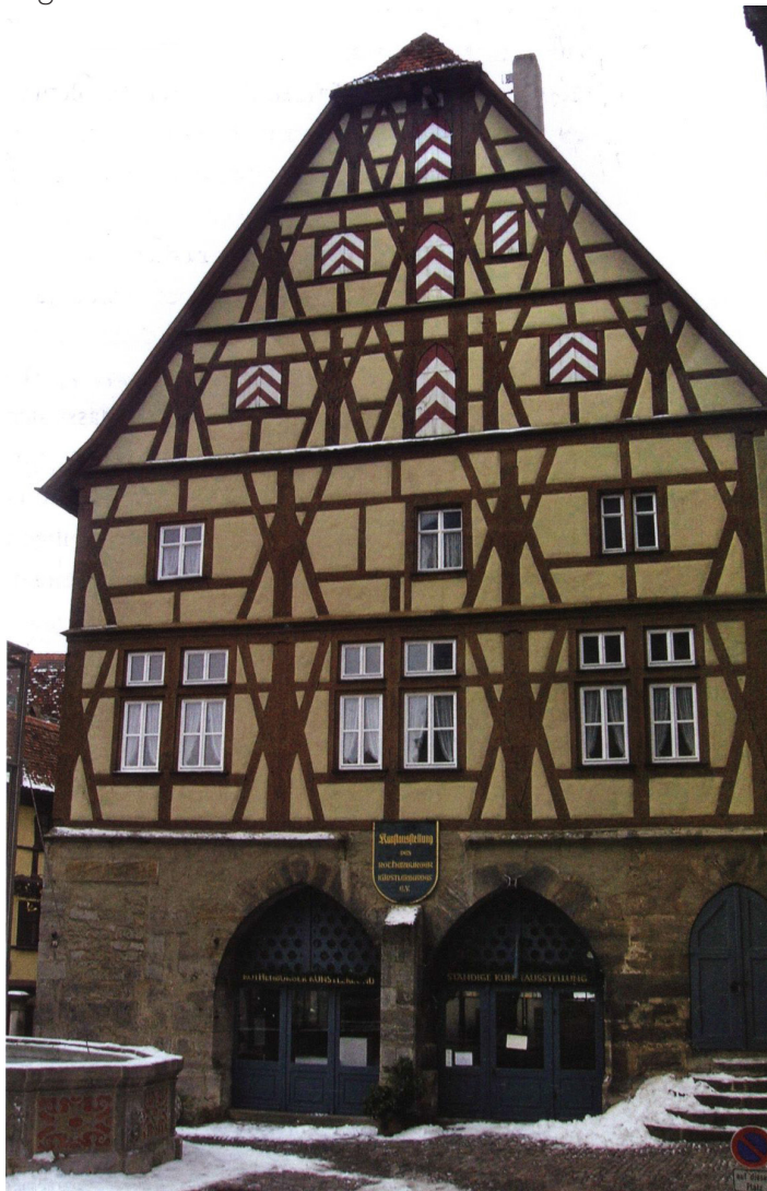
Abb. 10: Mittelalterliches Fachwerkhäus mit gemauertem Erdgeschoss
