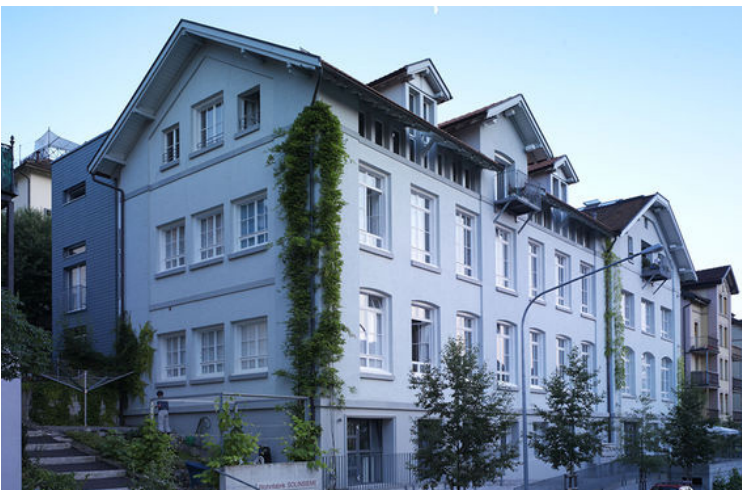
Abb. 63: Ansicht des Bestandsgebäudes
