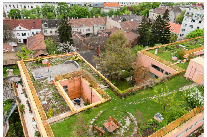
Abb. 60: Dachbegrünung als Erweiterung der Grünflächen
