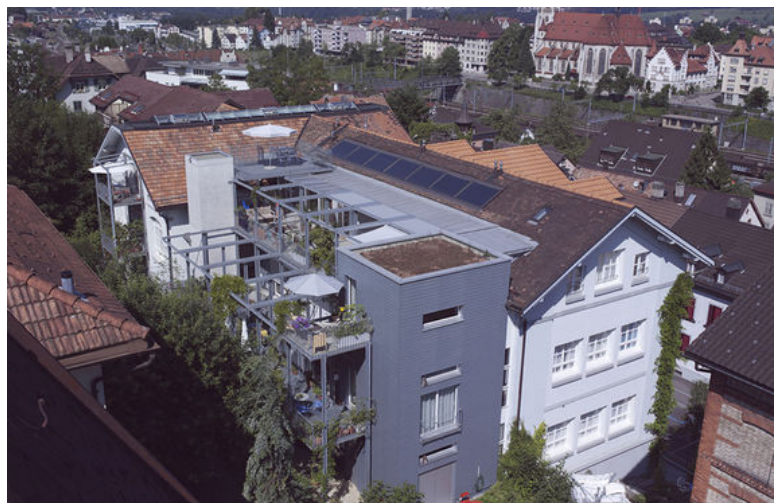
Abb. 64: Erweiterungsbau im hinteren Bereich
