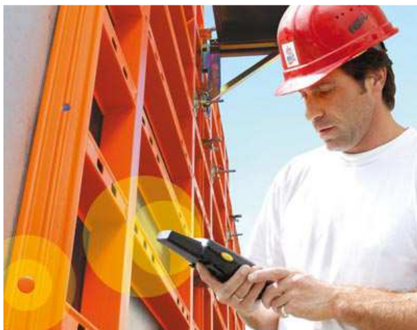
Bild 83 Schalungselemente mit RFID - Erkennung 462
