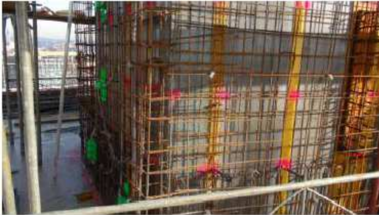
Bild 25 Markierungen der Schüttlagenhöhe 168
