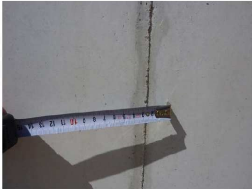
Bild 117 Sichtbarer Elementstoß 558
