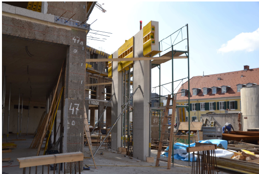
Bild 147 Lagesicherung des Musterbauteils mit Schrägstützen
