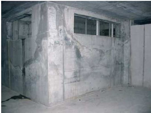
Bild 104 dunkle Verfärbungen aufgrund von Folienkontakt 522
