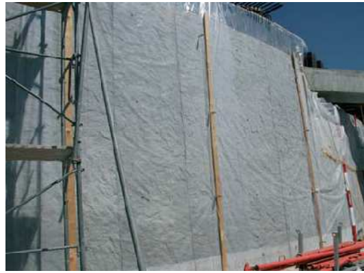
Bild 105 Richtige Nachbehandlung mit Stoffolie auf einer Hilfskonstruktion inkl. Abdeckung der Anschlussbewehrung 523
