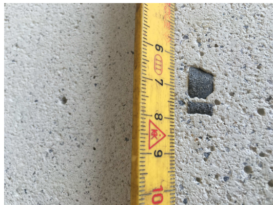
Bild 172 Sichtbarer Abstandhalter
