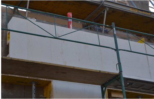
Bild 159 Gelbliche Verfärbungen auf der Betonoberfläche
