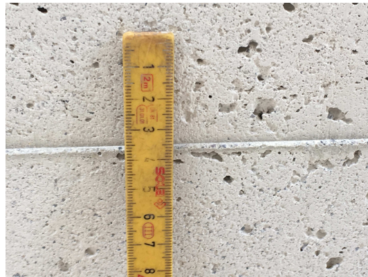
Bild 170 Sichtbare Elementfuge
