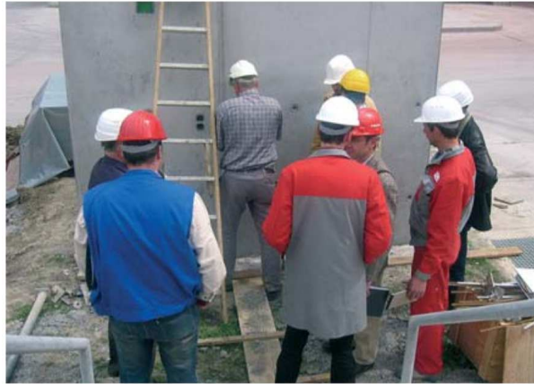
Bild 74 Dokumentation der erreichten Qualitäten und Festlegung einer Referenzfläche durch das Sichtbetonteam 414
