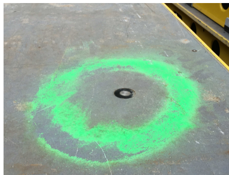
Bild 92 Concremote Messfühler-Wand auf der Schalunginnenseite
