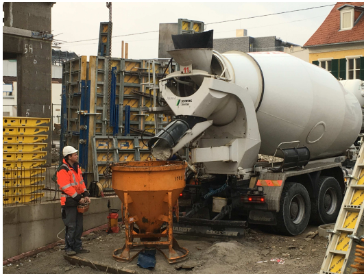
Bild 137 Entladung des Frischbetons in den Krankübel
