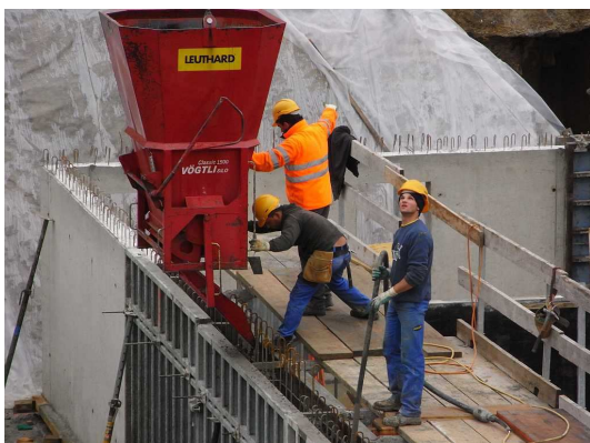
Bild 87 Bilddokumentation des Betonierprozesses 493
