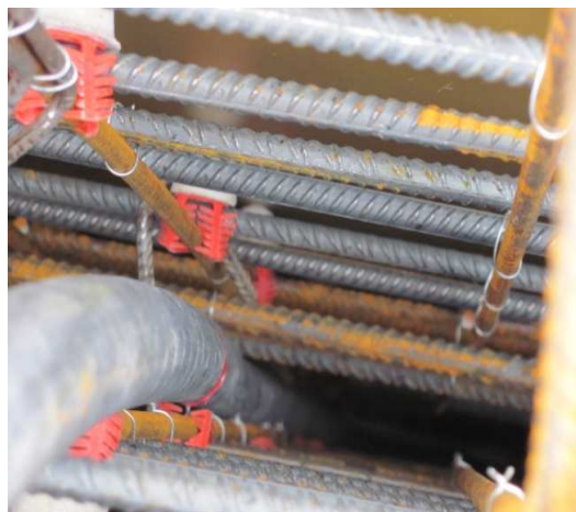
Bild 88 Kontakt zwischen Bewehrung und Innenrüttler 494
