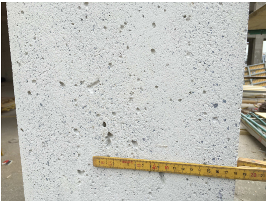
Bild 169 Betonoberfläche nach dem Sandstrahlen
