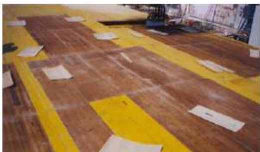
Bild 31 Schalhäute unterschiedlicher Einsatzzahlen 186
