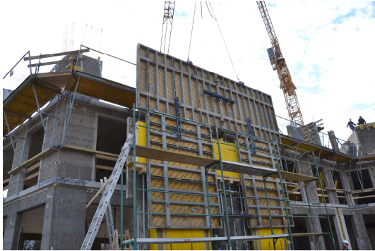
Bild 143 Abheben der Schließschalung
