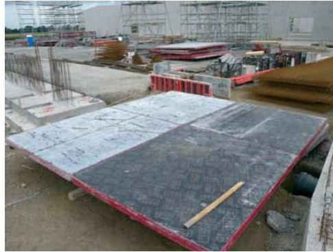
Bild 78 Schalhaut mit unterschiedlicher Einsatzhäufigkeit und unterschiedlichem Saugverhalten 456
