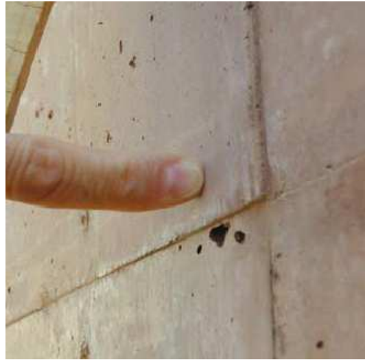
Bild 118 Sichtbarer Elementversatz 559
