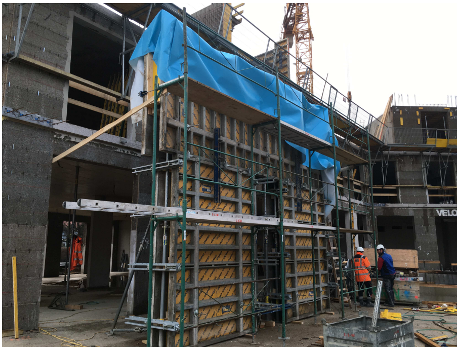
Bild 136 Vollständig eingeschaltetes Musterbauteil
