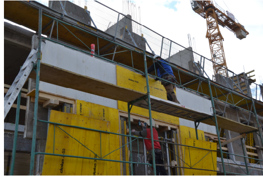
Bild 144 Entfernen der 3-SO Platten
