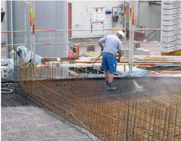
Bild 24 Entfernung loser Teile und Schmutz mittels Druckluft 164
