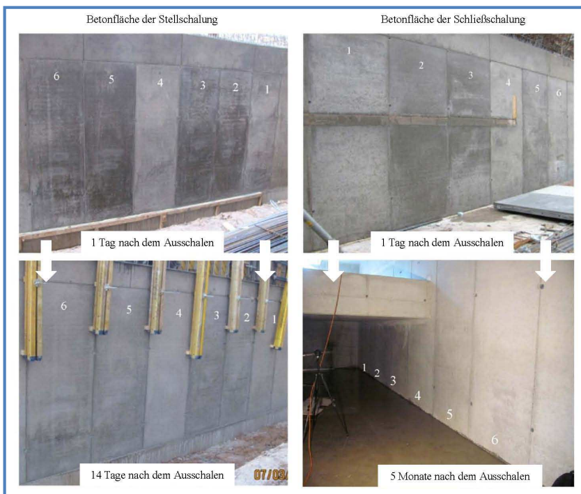
Bild 72 Wirkung: Unterschiedliche Farbtöne und Glanzgrade 410
