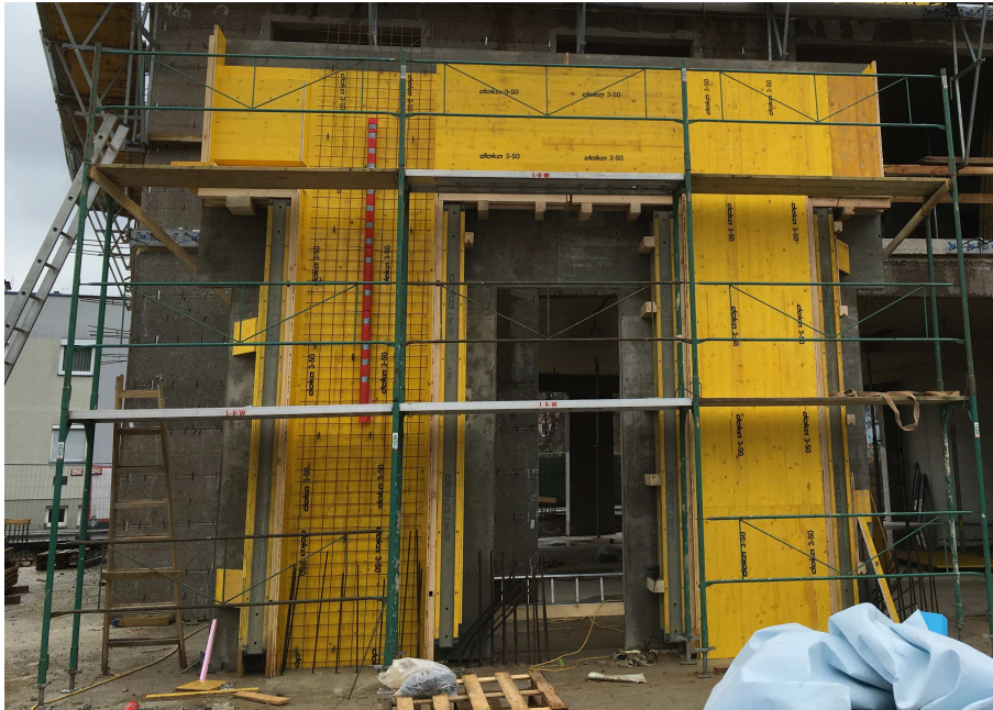
Bild 135 Befestigung des Regenwasserabflussrohres mit Hilfe einer Bewehrungsmatte
