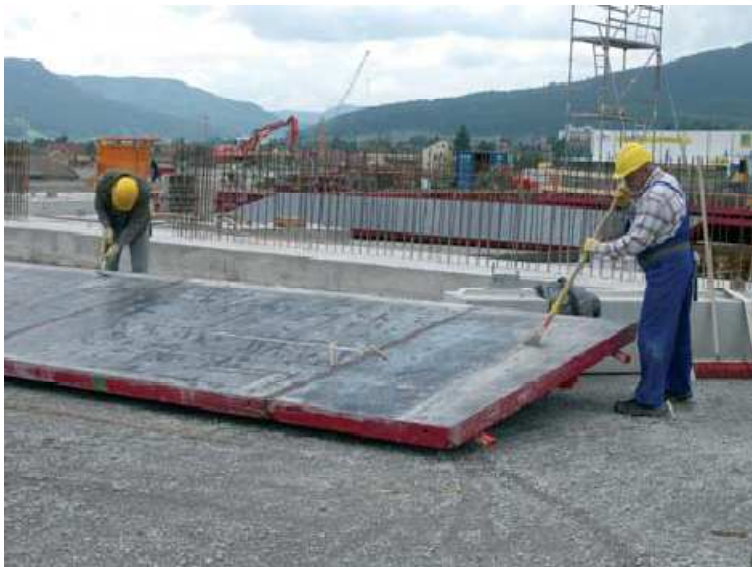
Bild 18 Reinigung der Schalung von Zementresten 141
