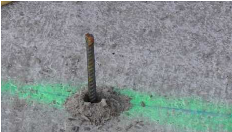
Bild 21 Markierung der Schalungsposition 153
