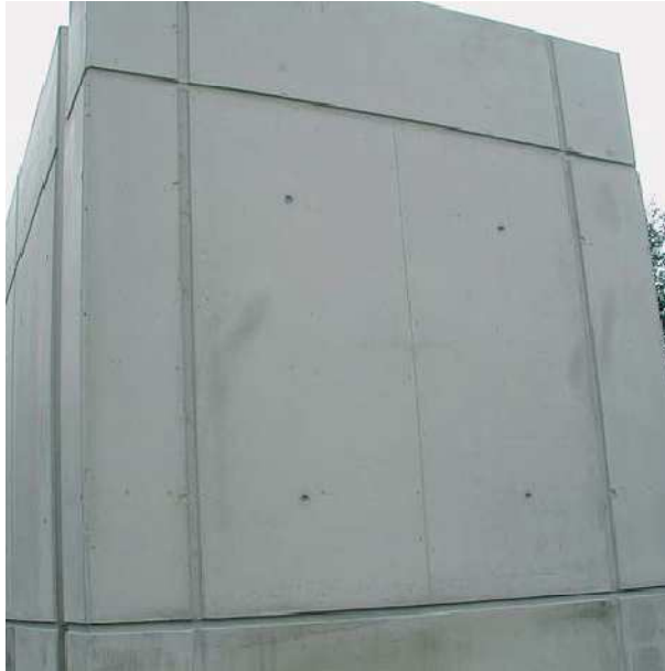
Bild 37 Mit Trapezleisten kaschierte Anschlussfugen 216
