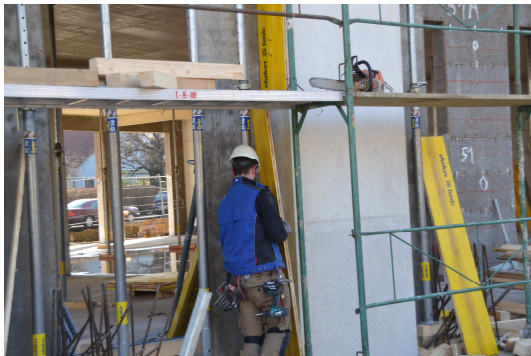
Bild 145 Entfernen der Randabschalung
