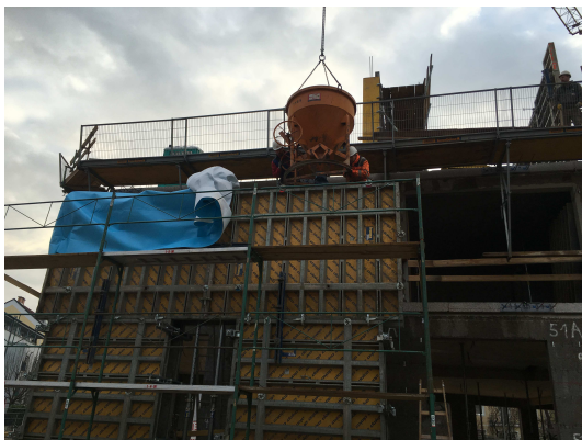
Bild 139 Betonage des Musterbauteils
