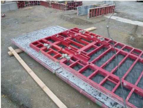
Bild 77 Falsche Schalungslagerung 455
