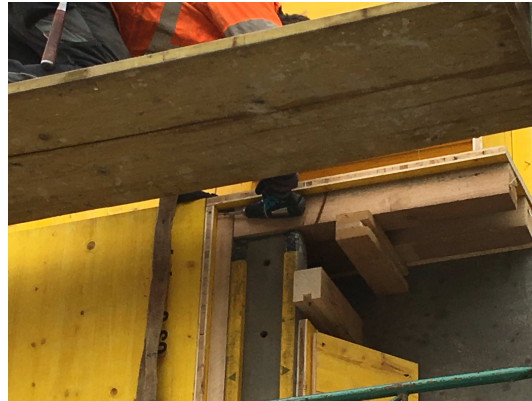
Bild 130 Befestigung der Schließschalung an der Randabschalung
