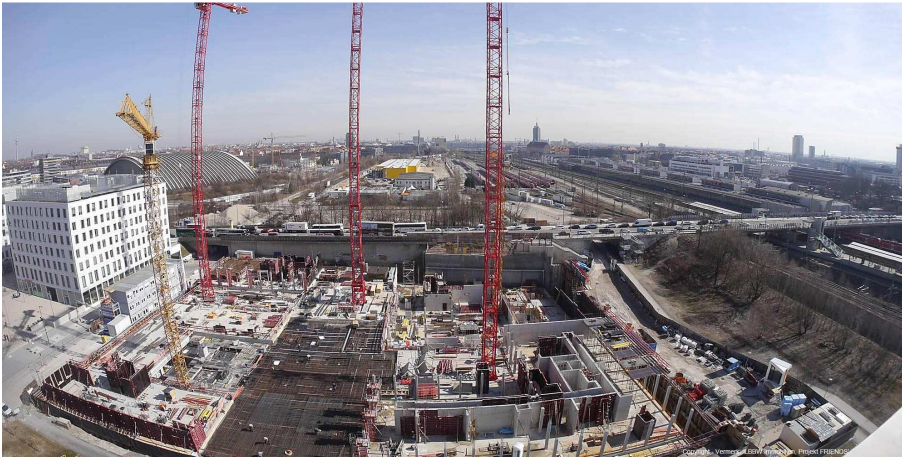
Bild 107 Baustellendokumentation durch eine ortsgebundene Webcam 525
