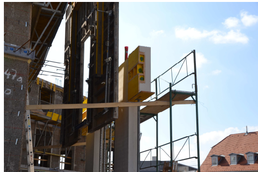
Bild 146 Abheben der Stellschalung
