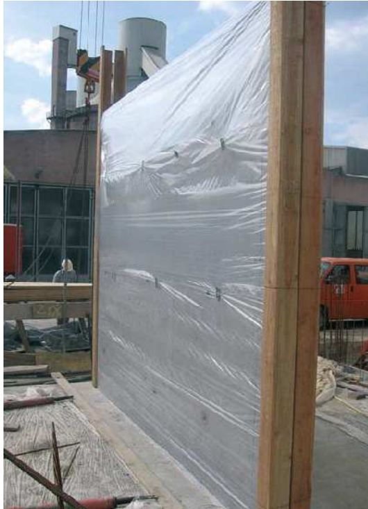
Bild 30 Hilfskonstruktion um Folienkontakt zu vermeiden 182
