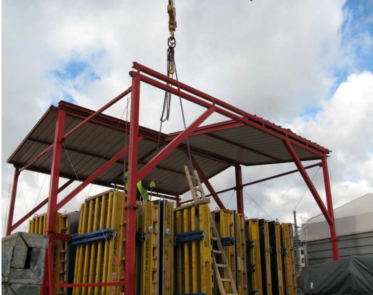
Bild 17 Stehende Lagerung der Schalungselemente 135
