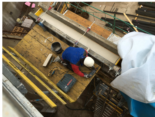
Bild 140 Äußere Verdichtung mittels Schlagbohrmaschine
