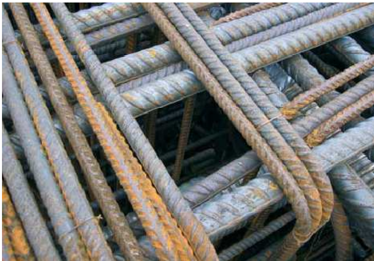
Bild 23 Rüttel- und Einfüllöffnung in der Bewehrung 162
