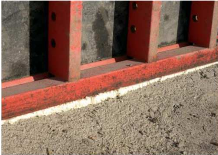
Bild 22 Mit Schaum abgedichteter Schalungsfuß 156
