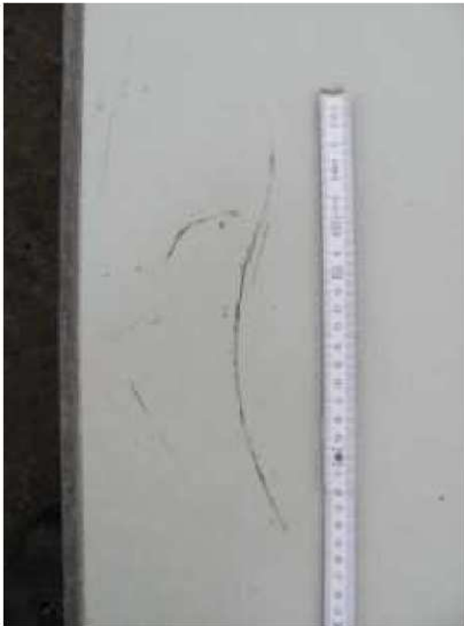
Bild 81 Ursache: zerkratzte Schalhaut 459
