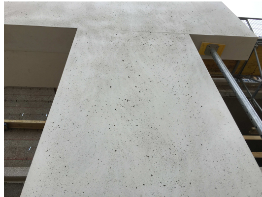
Bild 168 Sandgestrahlte Fassadenstütze
