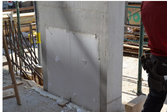
Bild 148 Aussparung durch EPS-Platte
