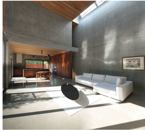
Bild 14 Sichtbetonflächen im Wohnraum 127
