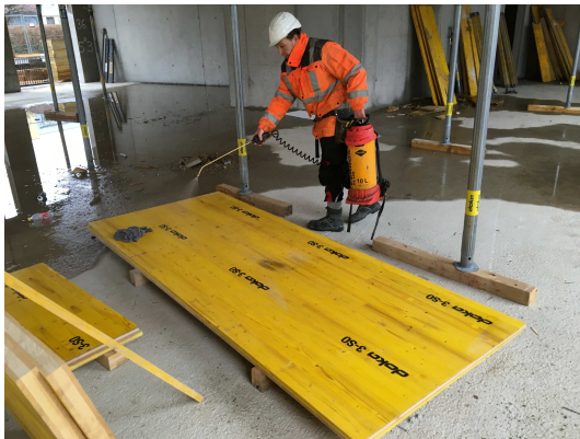
Bild 133 Trennmittelauftrag mittels Sprühflasche auf die Schalhaut der Schließschalung
