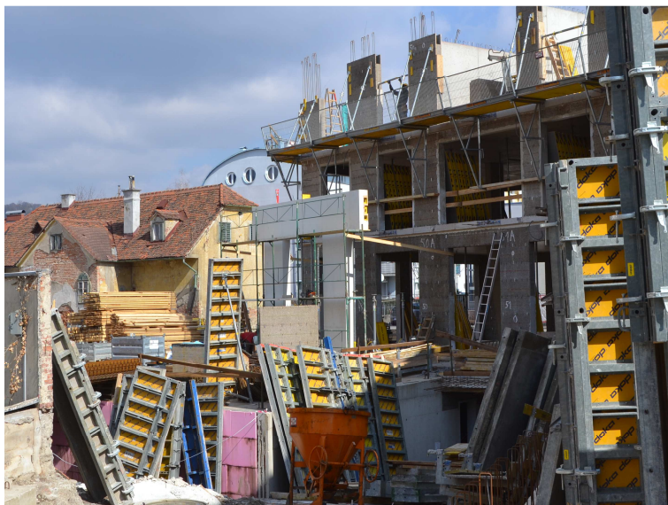
Bild 165 Musterbauteil: Blick von dem an das Grundstück angrenzenden Gehwegs
