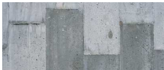
Bild 32 Farbunterschiede durch unterschiedlich alte Bretter 187
