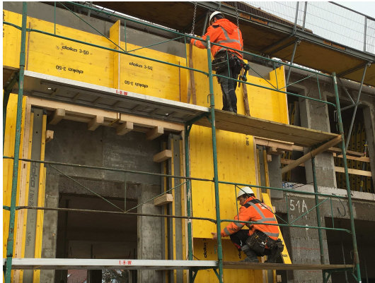
Bild 129 "Einfädeln" der Schalhaut für die Schließschalung
