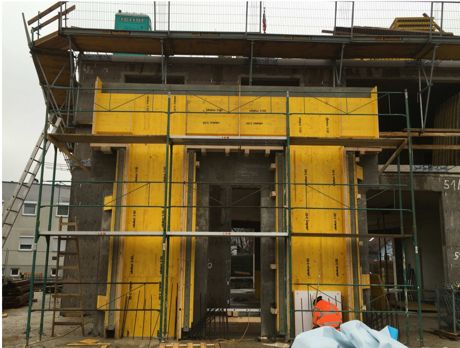
Bild 127 Stellschalung des Musterbauteils
