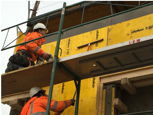
Bild 131 Abziehen des überschüssigen Trennmittels auf der Stellschalung
