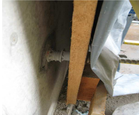
Bild 101 Hilfskonstruktion mit Abstandhalter 519
