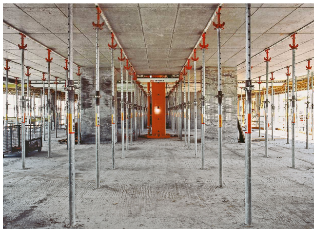
Bild 36 Rahmenschalung Skydeck - Zustand nach dem Frühausschalen 203
