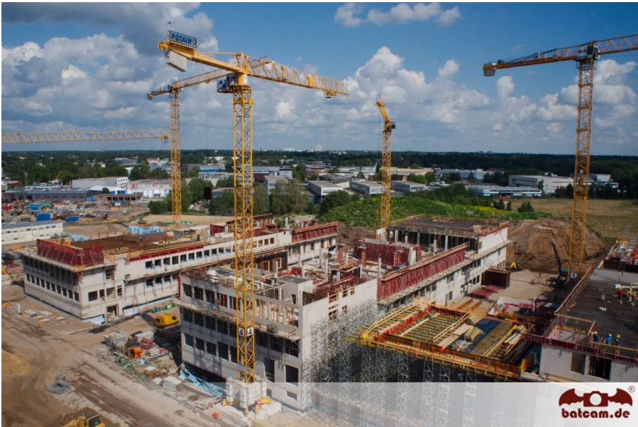
Bild 108 Baustellendokumentation durch eine Drohne 526
