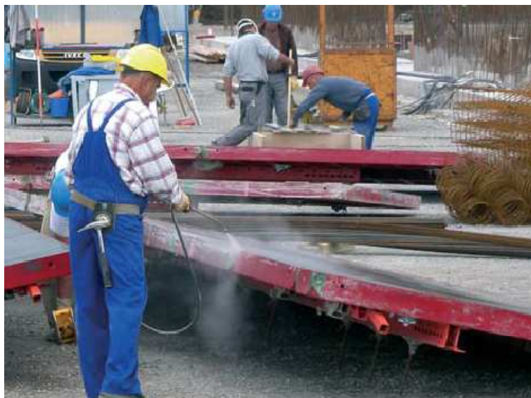
Bild 20 Trennmittelauftrag mit Spritzdüse 151
