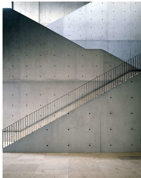
Bild 12 Glatte Sichtbetonfläche durch die Anwendung einer nichtsaugenden Schalhaut 125
