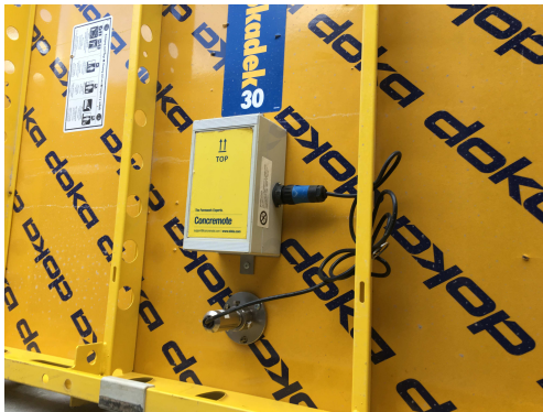
Bild 91 Einsatz Concremote Messfühler-Wand
