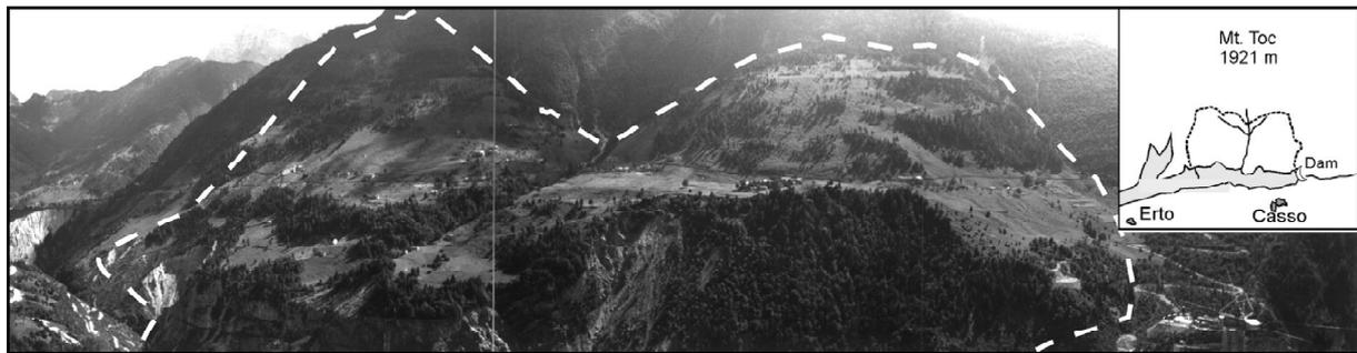
**Abbildung 20 Südseite des Flusstales mit Bereich der Rutschung (gestrichelte Linie) (Genevois & Ghirotti, 2005)**
