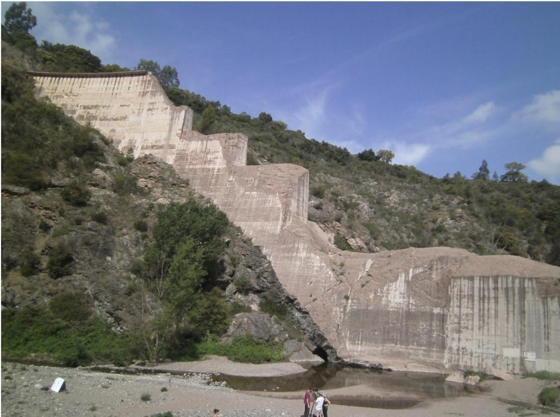
Abbildung 24 Staumauer von Malpasset nach dem Versagen (2014)
