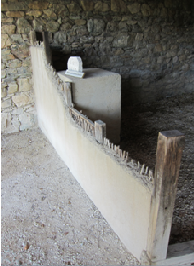
038 Wandaufbau, Trennwand im Wohnbereich
