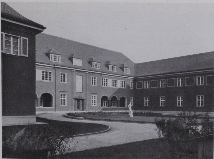
Abb. 16. Innenhof des Anbaues.
