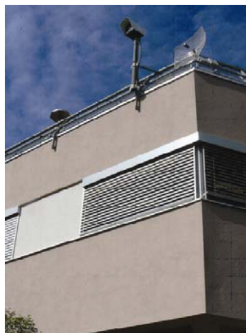
Abb. 8.3: Typische 5 GHz WLAN Richtfunkantenne und Montagesituation, Quelle: Fa. Wimo [91]
