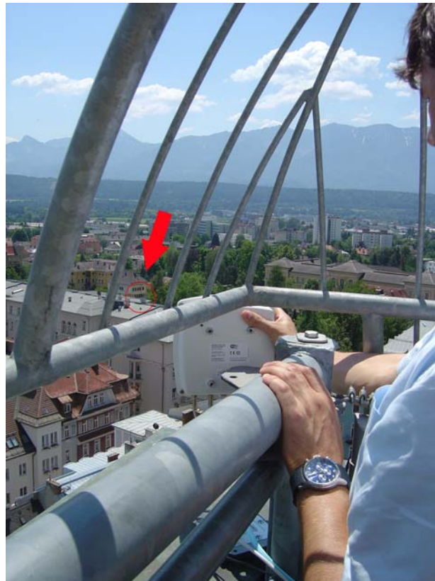
Abb. 5.2: Blick vom Kirchturm zur WLAN Gegenstelle
