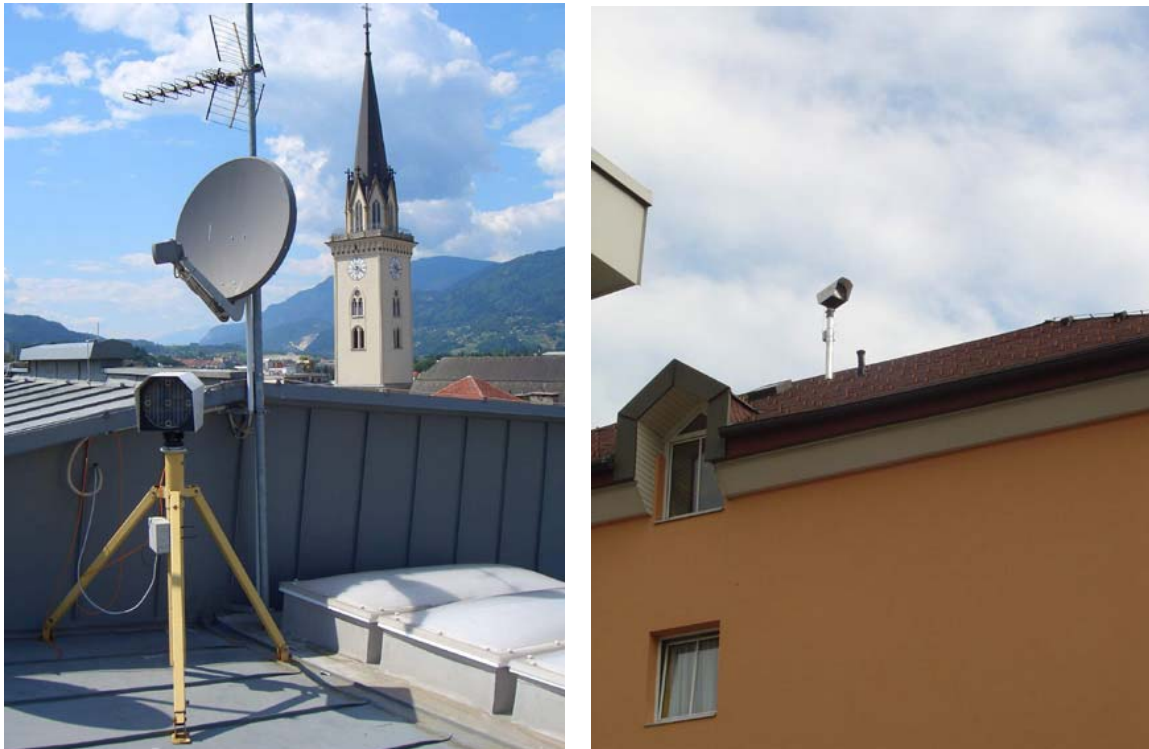
Abb. 5.3: Montagesituation der FSO Einheiten
